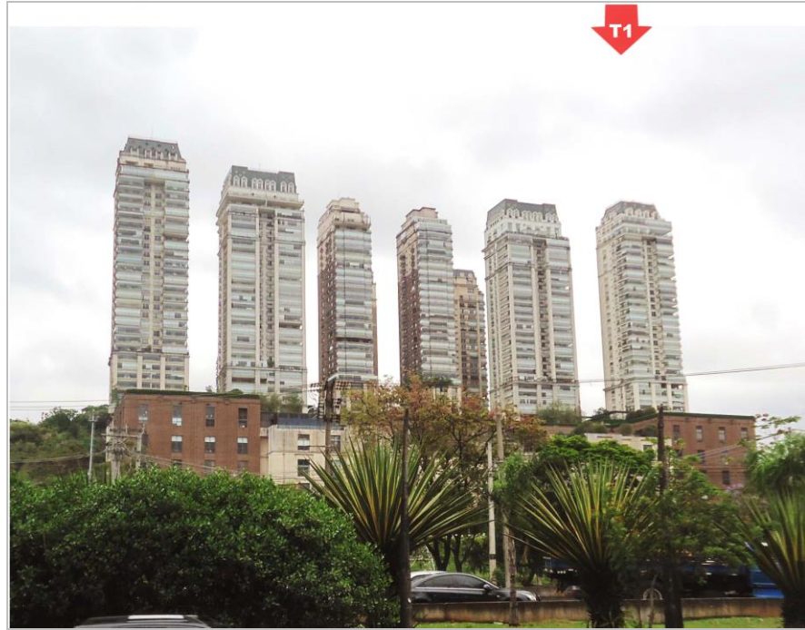
Condomínio Cidade Jardim - Setores Comercial e Residencial Torre 1 / Edifício Begônias - à direita (vista frontal)
