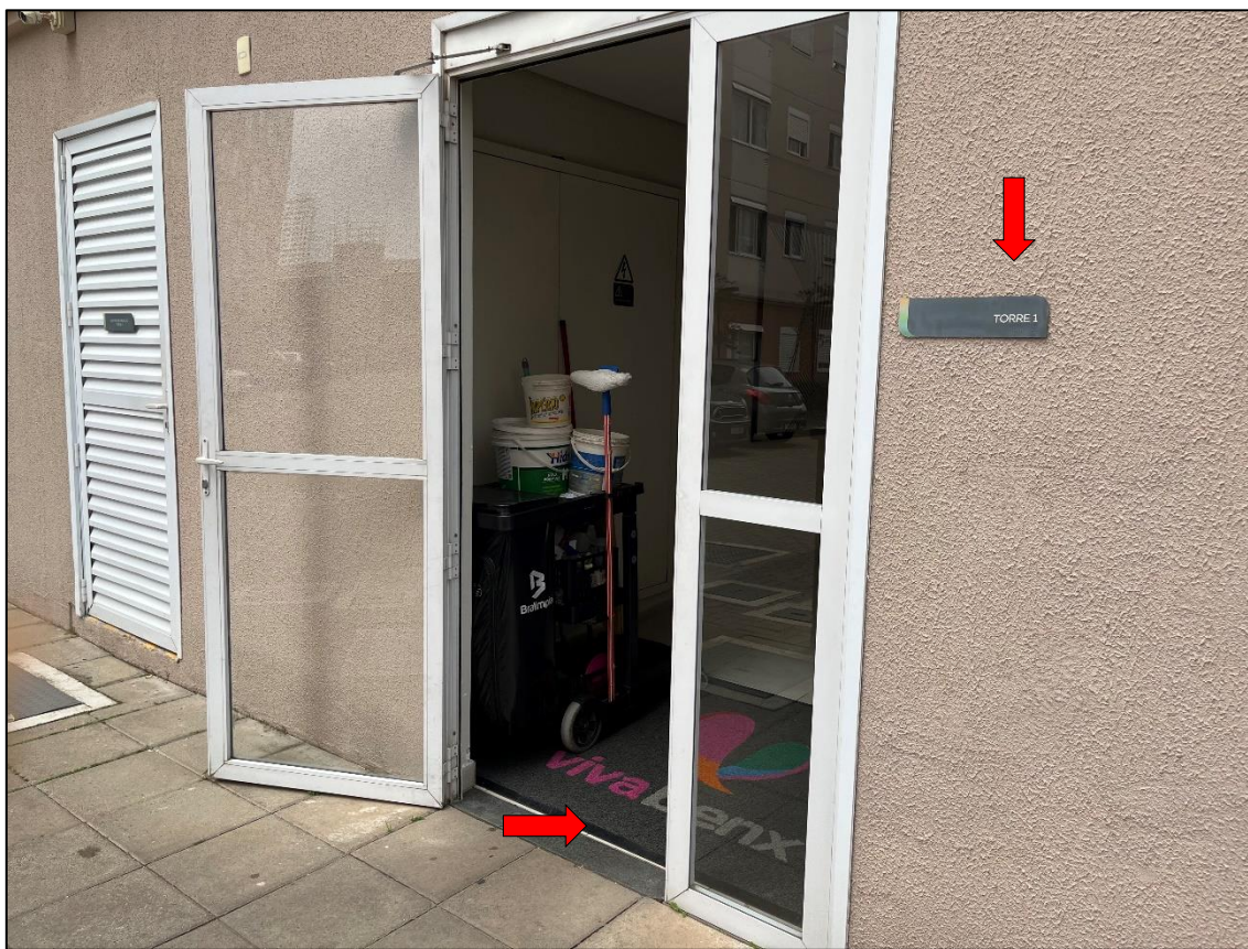
Foto 33: Vista das identificações na Torre I onde está localizado o imóvel avaliando.
