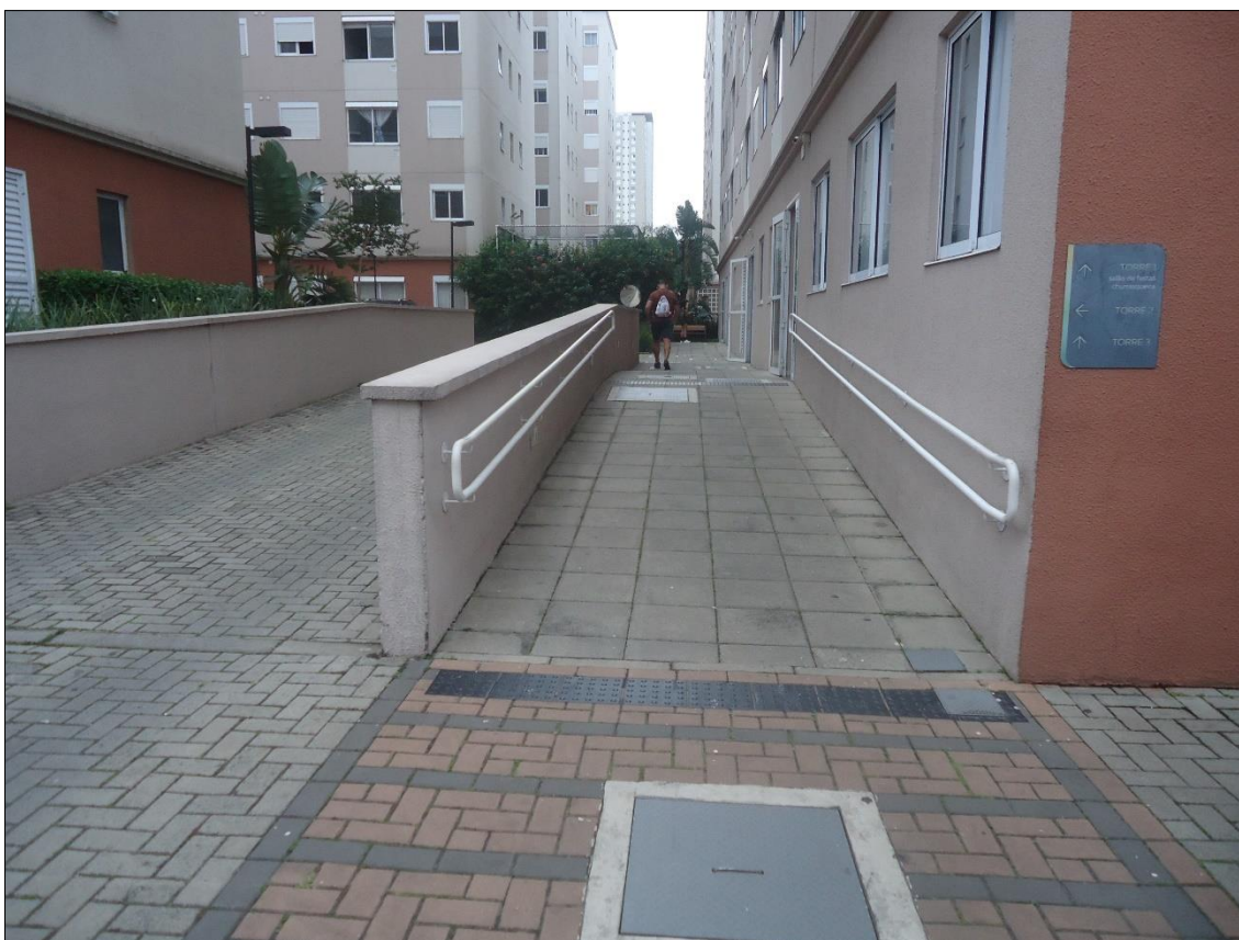
Foto 07: Vista interna do condomínio, acesso aos edifícios e vagas de estacionamento.
