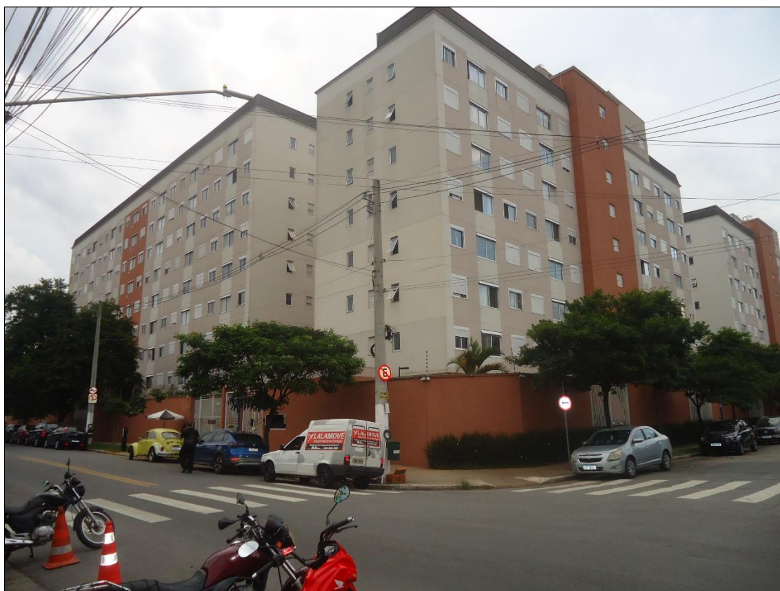
Foto 04: Vista do acesso e entorno da Rua Xavier Kraus onde se localiza o imóvel avaliando.
