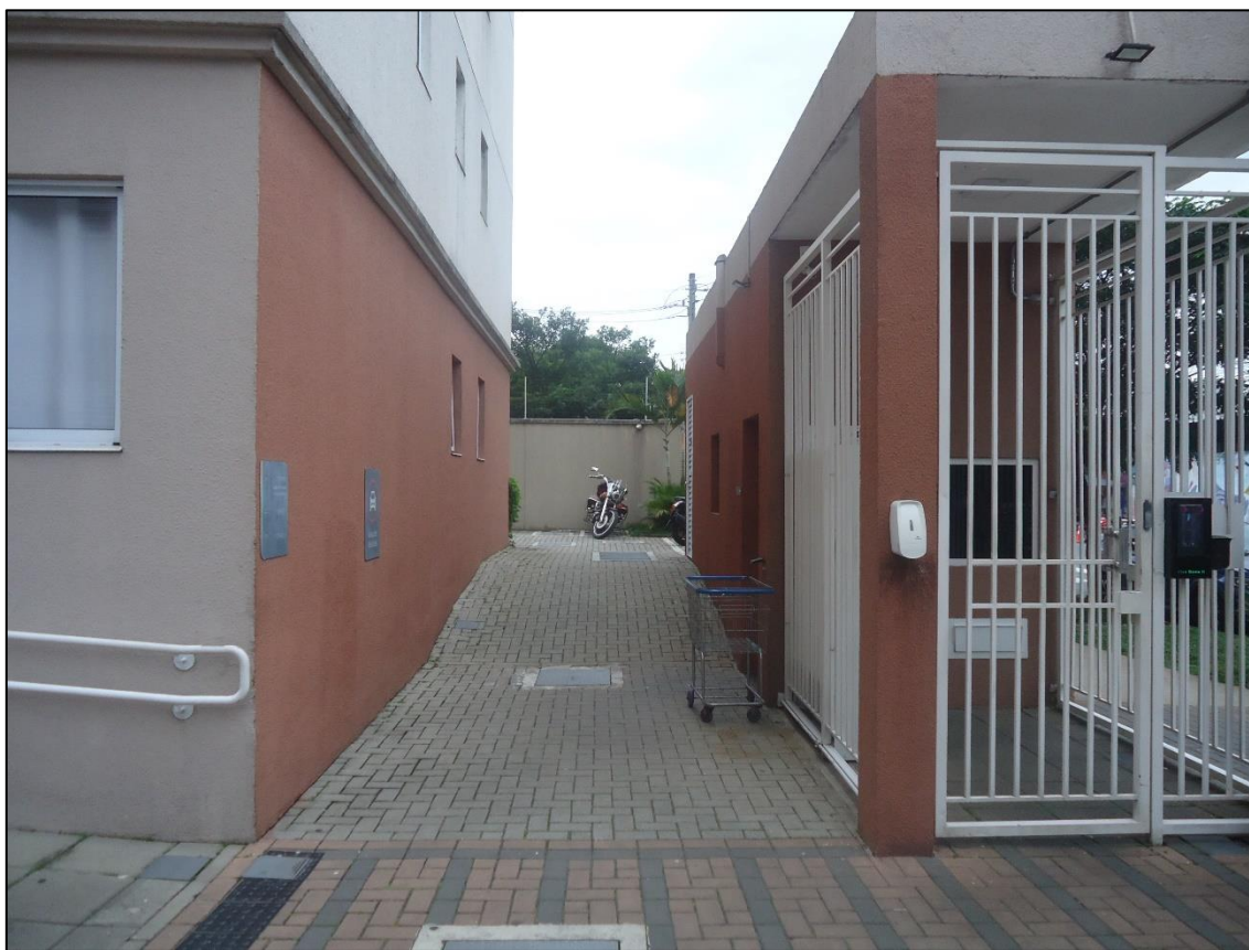
Foto 06: Vista interna do condomínio, acesso aos edifícios e portaria.
