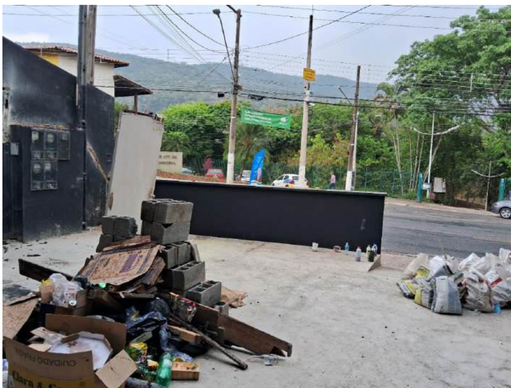
Vistas do 1.º pavimento BAR/LANÇONETE – “BAR DO GERENTE” (em reformas/adaptação)
