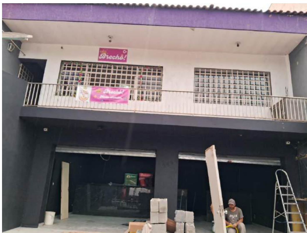
Vistas do 1.º pavimento BAR/LANCHONETE – “BAR DO GERENTE” (em reformas/adaptação)
