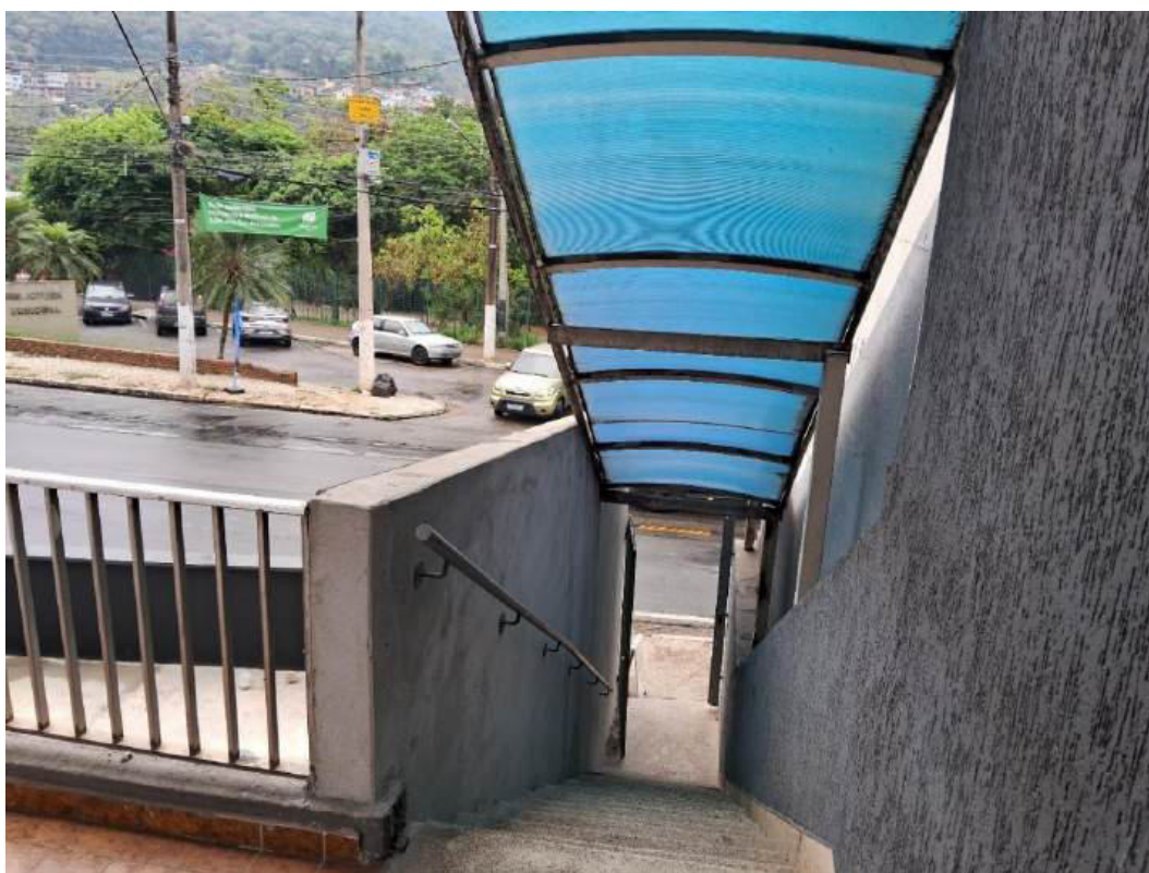
Vistas do ACESSO INDEPENDENTE ao 2.º pavimento e fundos do imóvel
