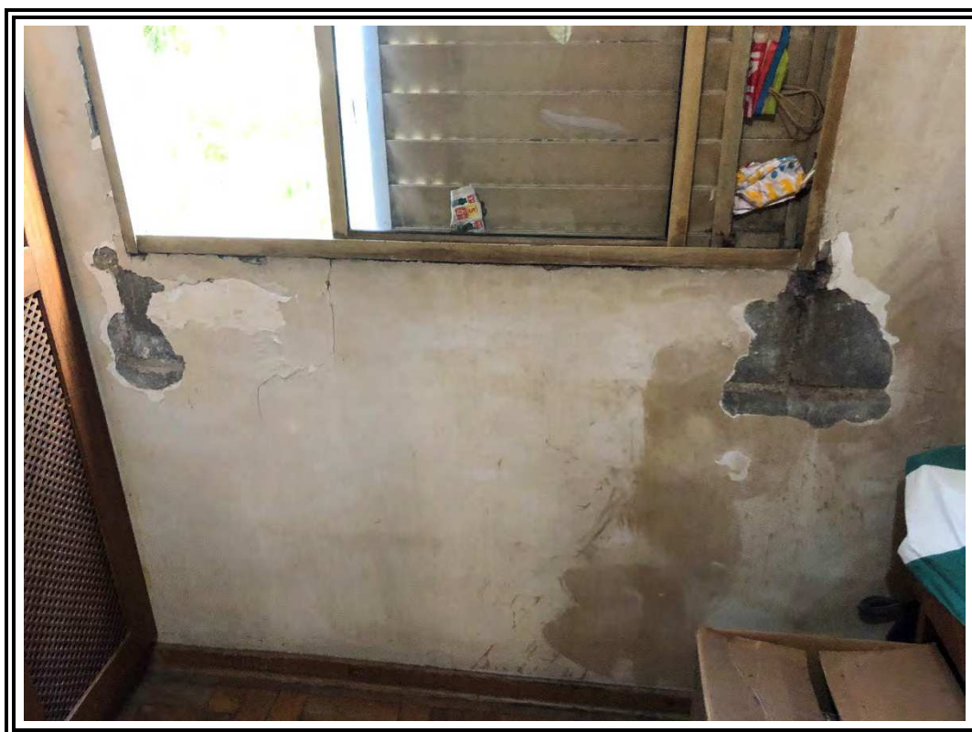
Fotos nº 23 e 24: Vista da parede do dormitório 2 com detalhe do acabamento deteriorado devido a infiltrações
