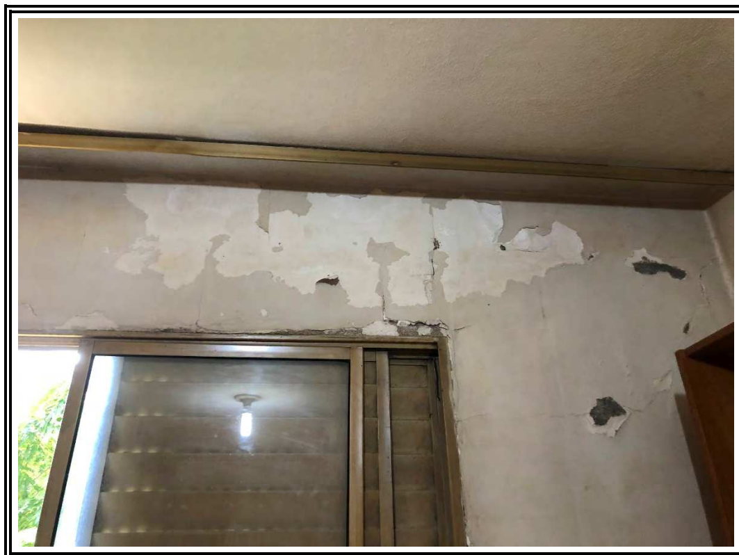
Fotos nº 23 e 24: Vista da parede do dormitório 2 com detalhe do acabamento deteriorado devido a infiltrações
