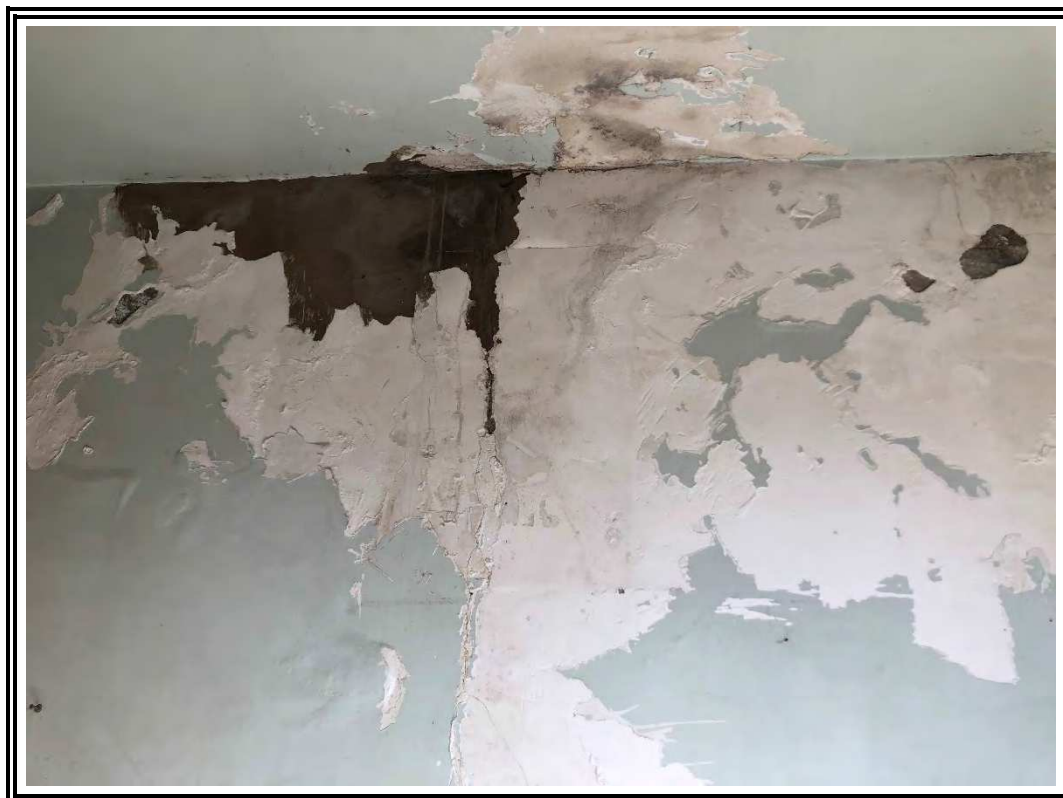
Fotos nº 20 e 21: Vista das paredes do dormitório 1 com detalhe do acabamento deteriorado devido a infiltrações
