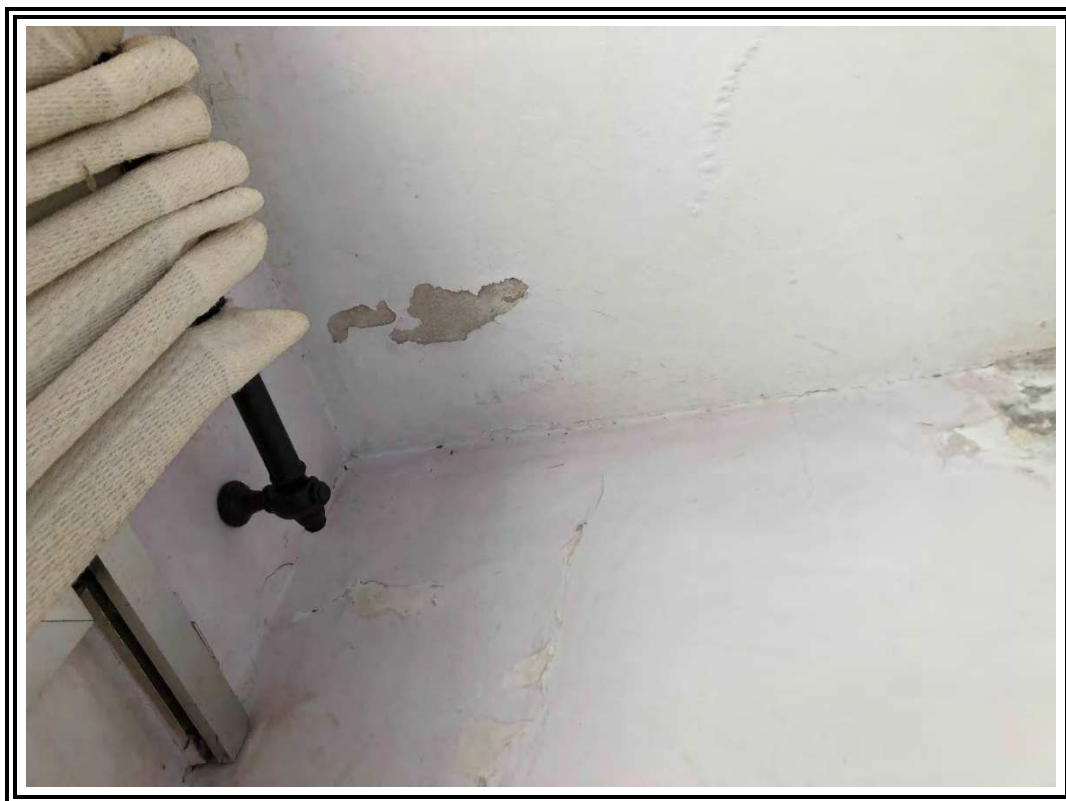
Fotos nº 11 e 12: Vista de uma das paredes e forro com trincas, umidade localizada e acabamento comprometido
