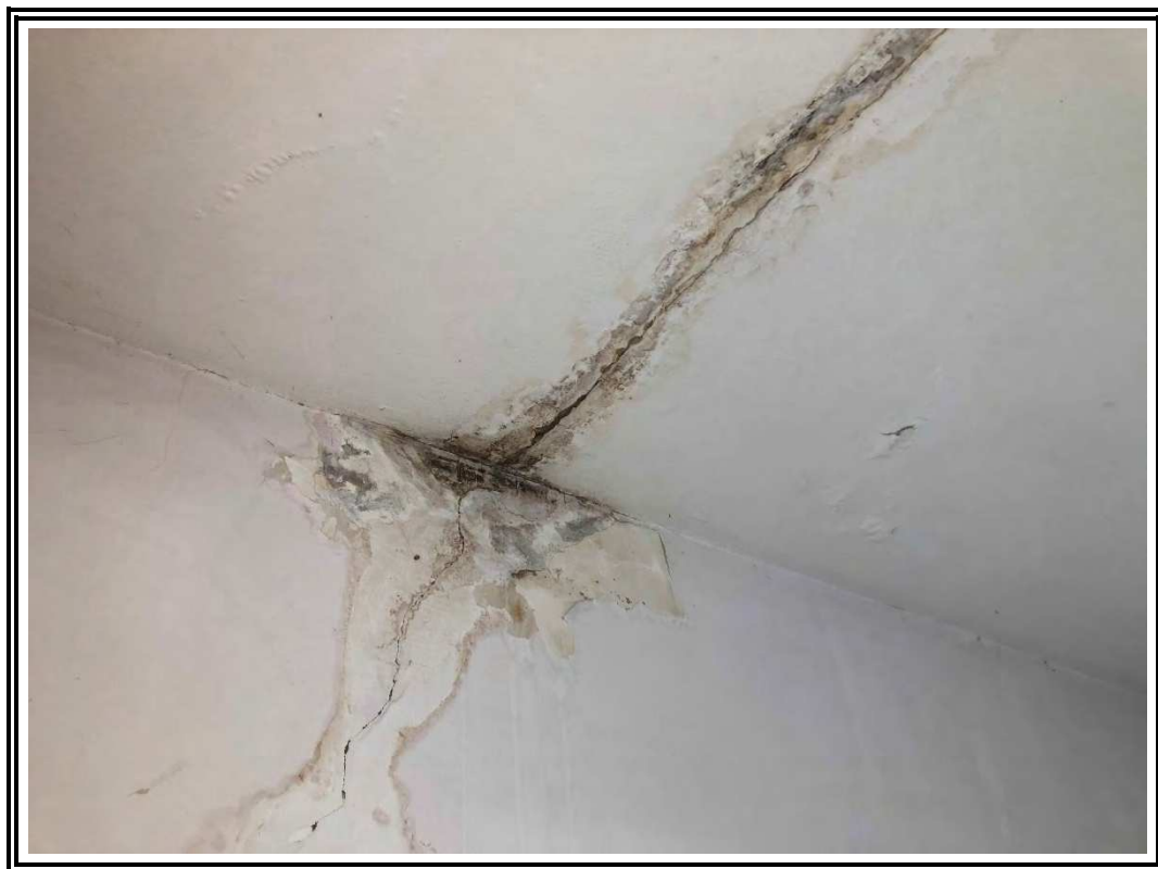
Fotos nº 11 e 12: Vista de uma das paredes e forro com trincas, umidade localizada e acabamento comprometido
