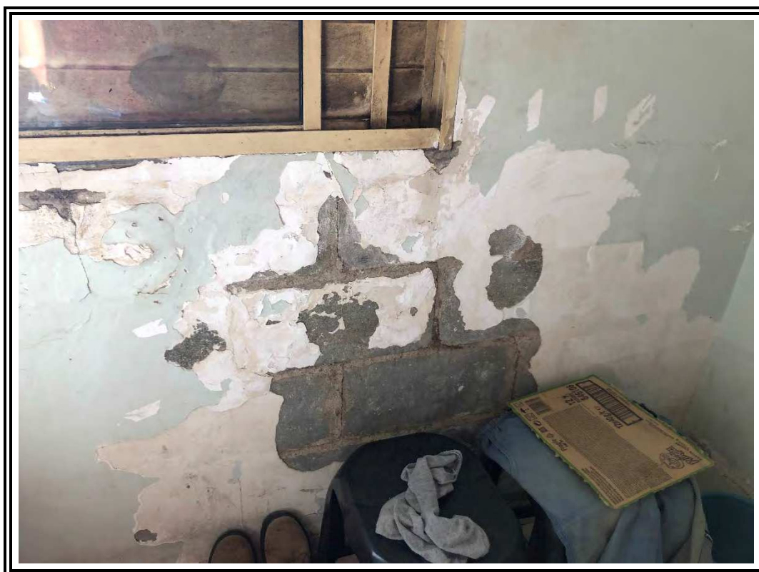
Fotos nº 20 e 21: Vista das paredes do dormitório 1 com detalhe do acabamento deteriorado devido a infiltrações
