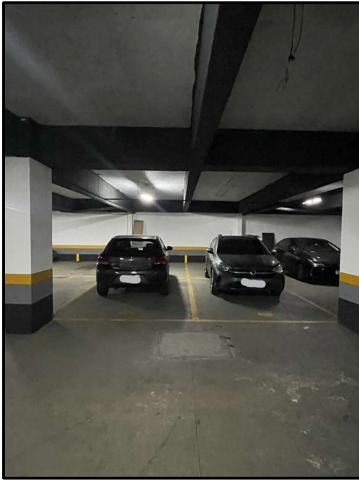
Foto 28: 2º pavimento subsolo – vagas de garagem do apartamento 11
