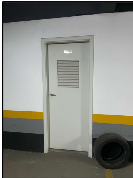
Foto 30: 2º pavimento subsolo – depósito do apartamento 11
