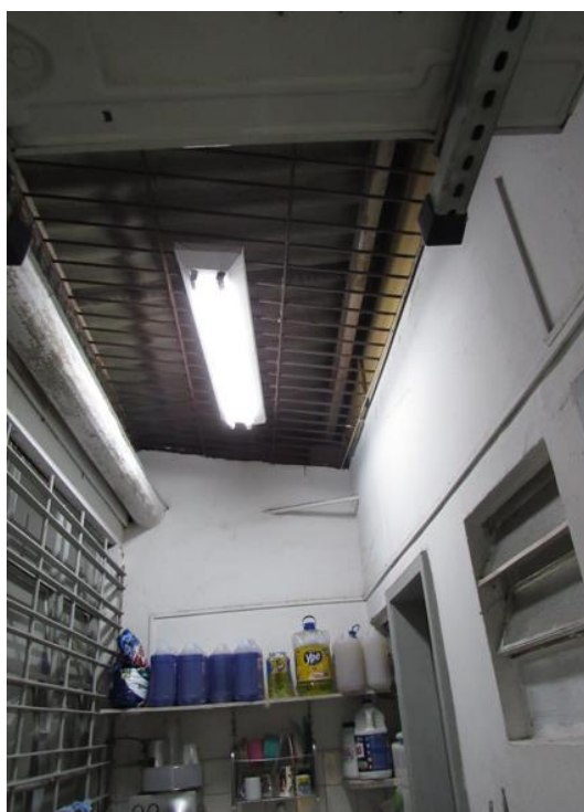
Foto 6 – Área de Serviço no pavimento térreo do imóvel avaliando.
