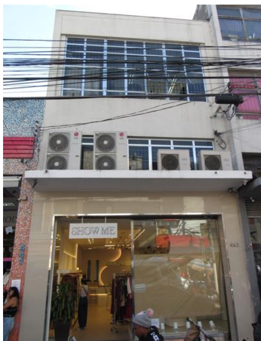
Foto 1 – Faixada do imóvel avaliando.
