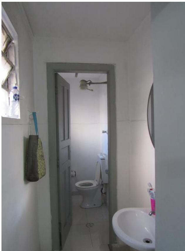
Foto 11 – Lavabo no terceiro pavimento do imóvel avaliando.
