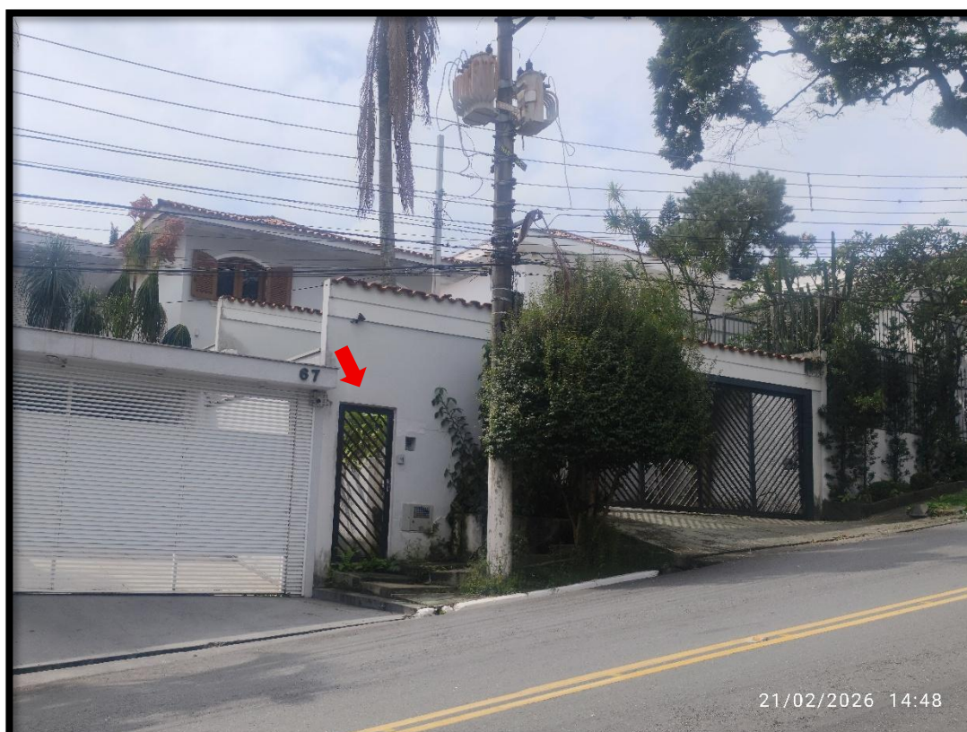
FOTO 09 – ENTRADA SOCIAL PELO LADO ESQUERDO DO IMÓVEL.
