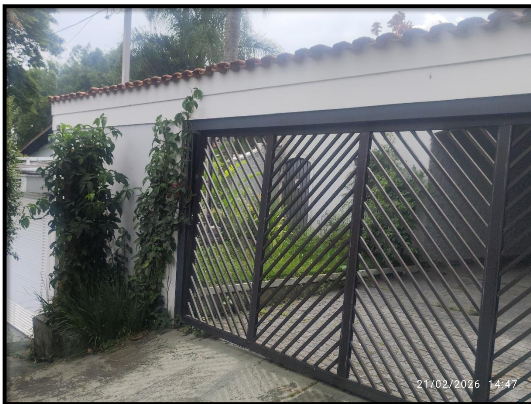
FOTO 08 – ENTRADA SOCIAL PELO LADO ESQUERDO DO IMÓVEL.
