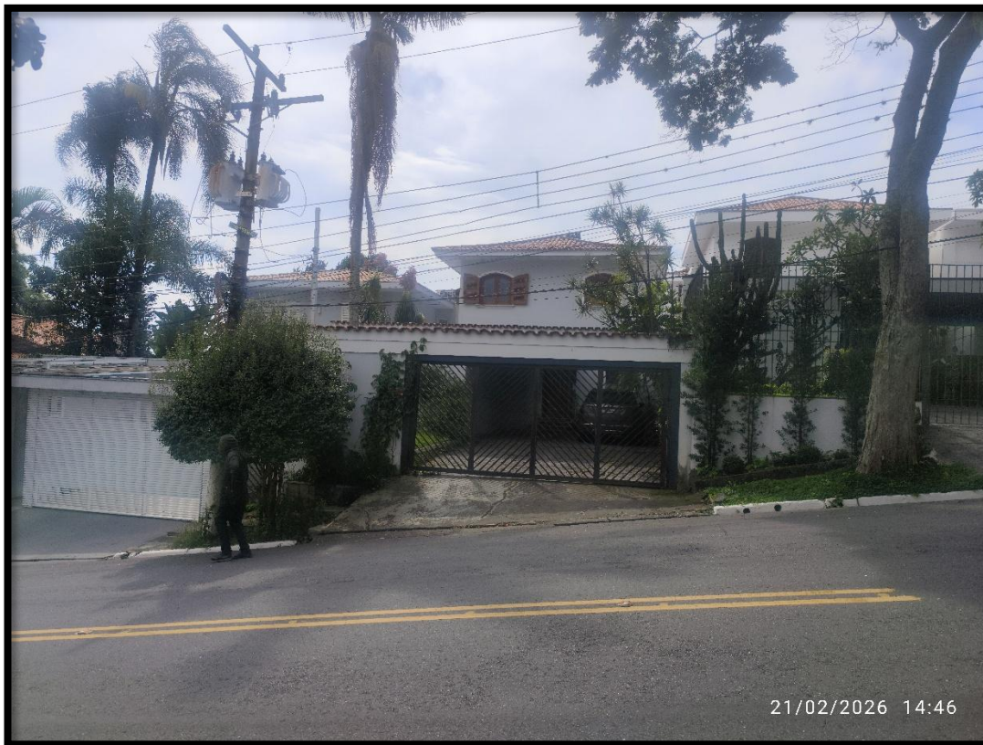
FOTO 01 – FACHADA DO IMÓVEL.
