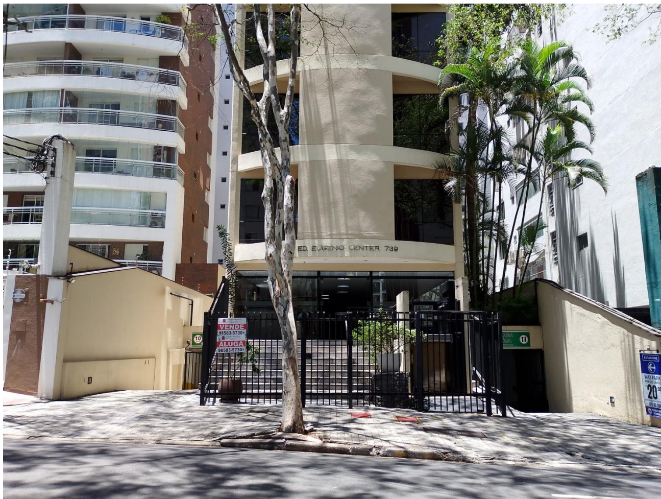
Figura 3 – Fachada do edifício
