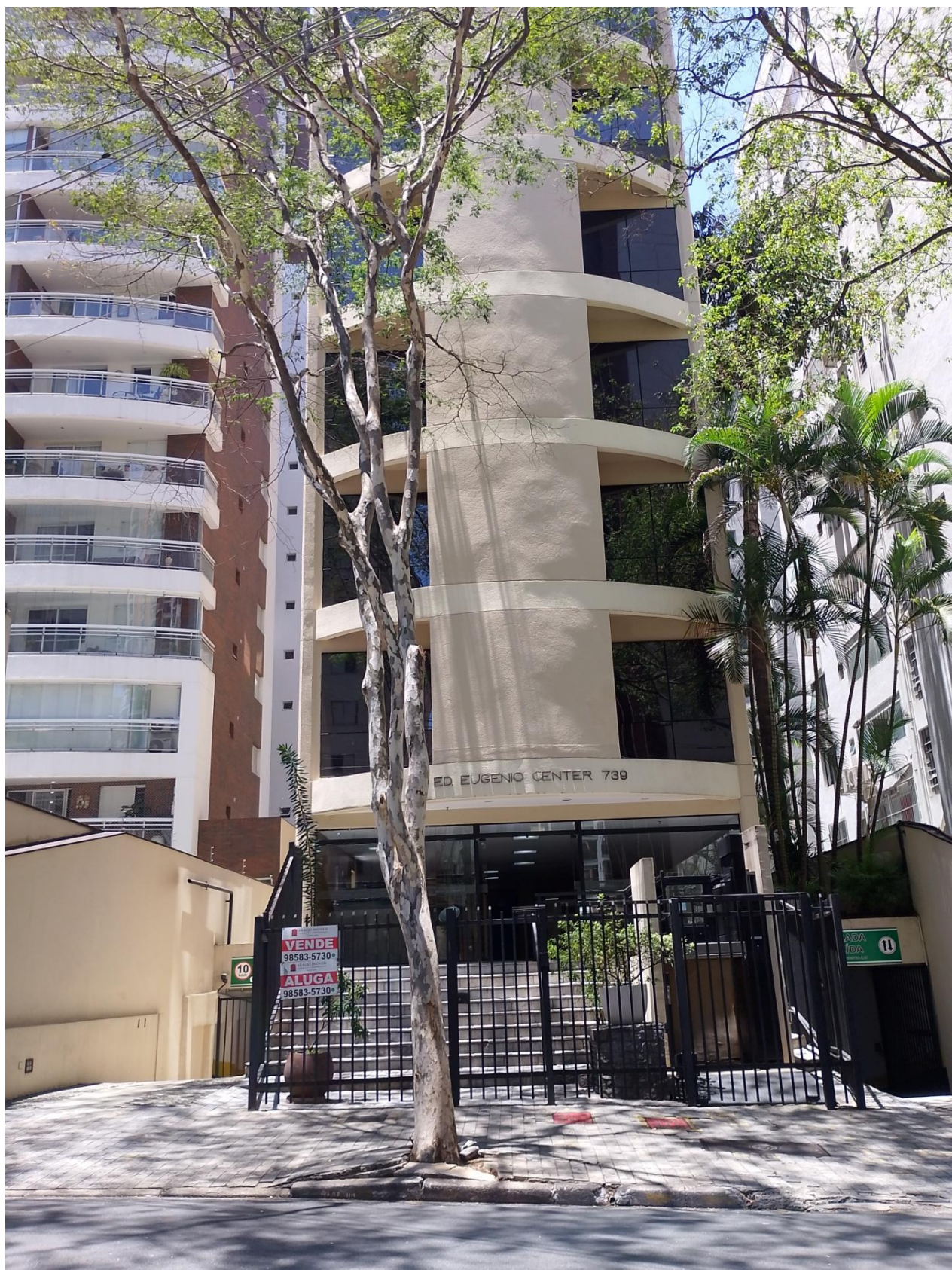
Figura 4 – Fachada do edifício
