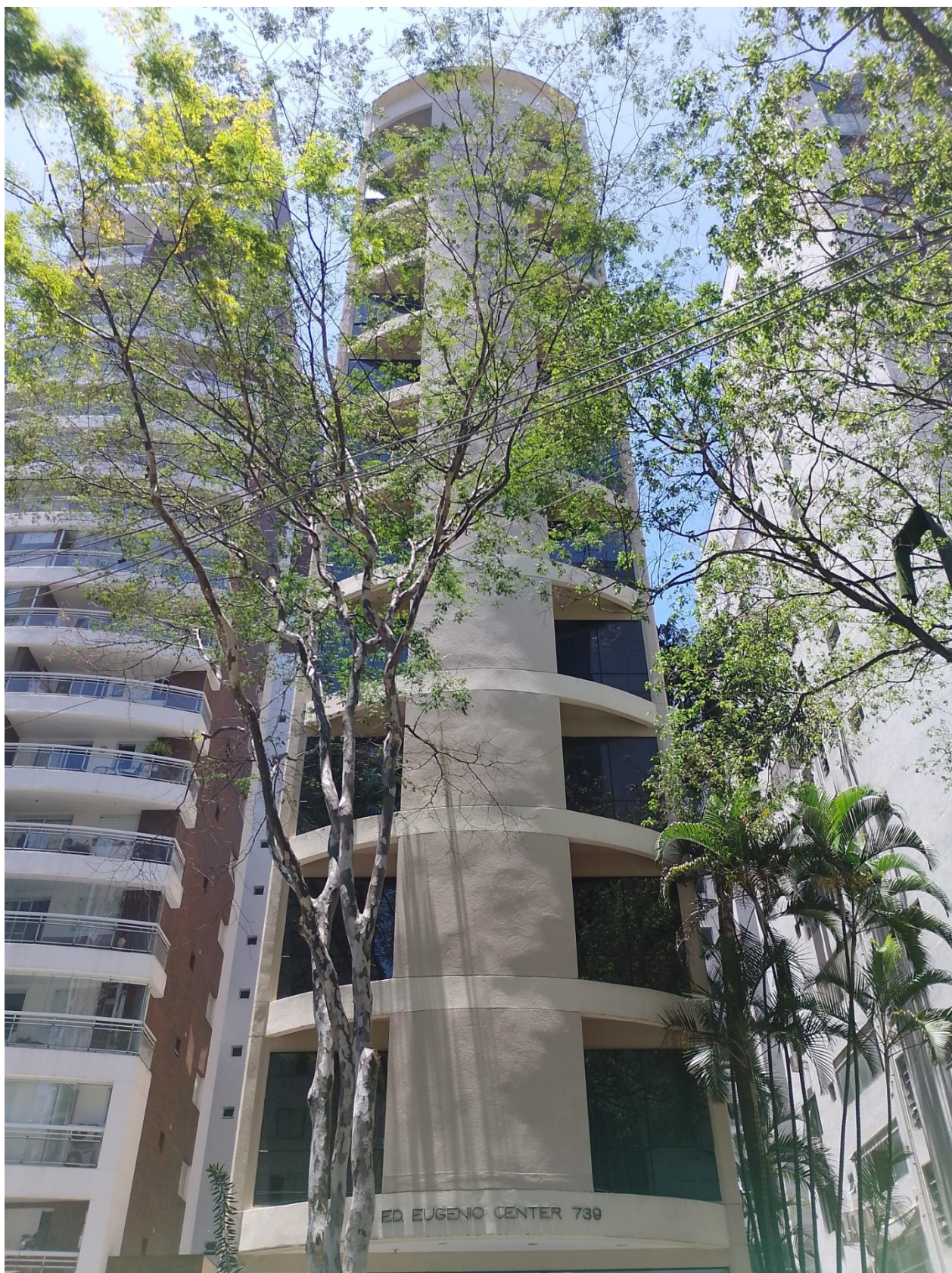
Figura 5 – Fachada do edifício
