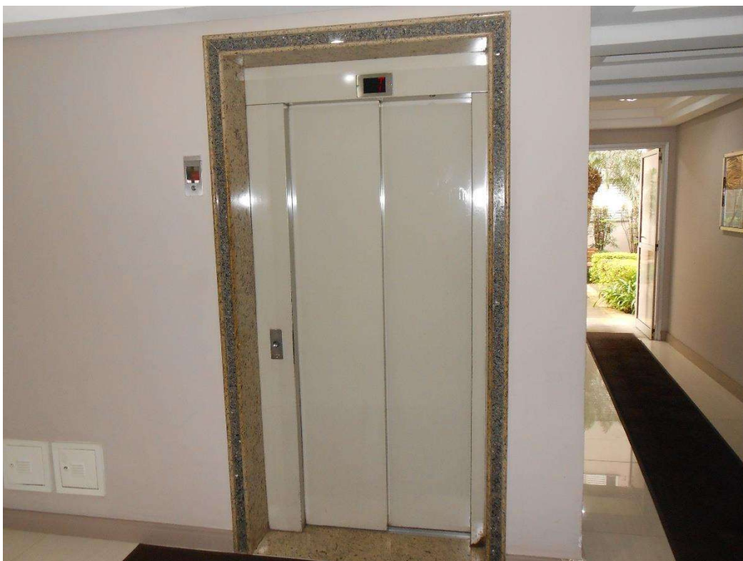
Foto 17: Hall de elevadores
