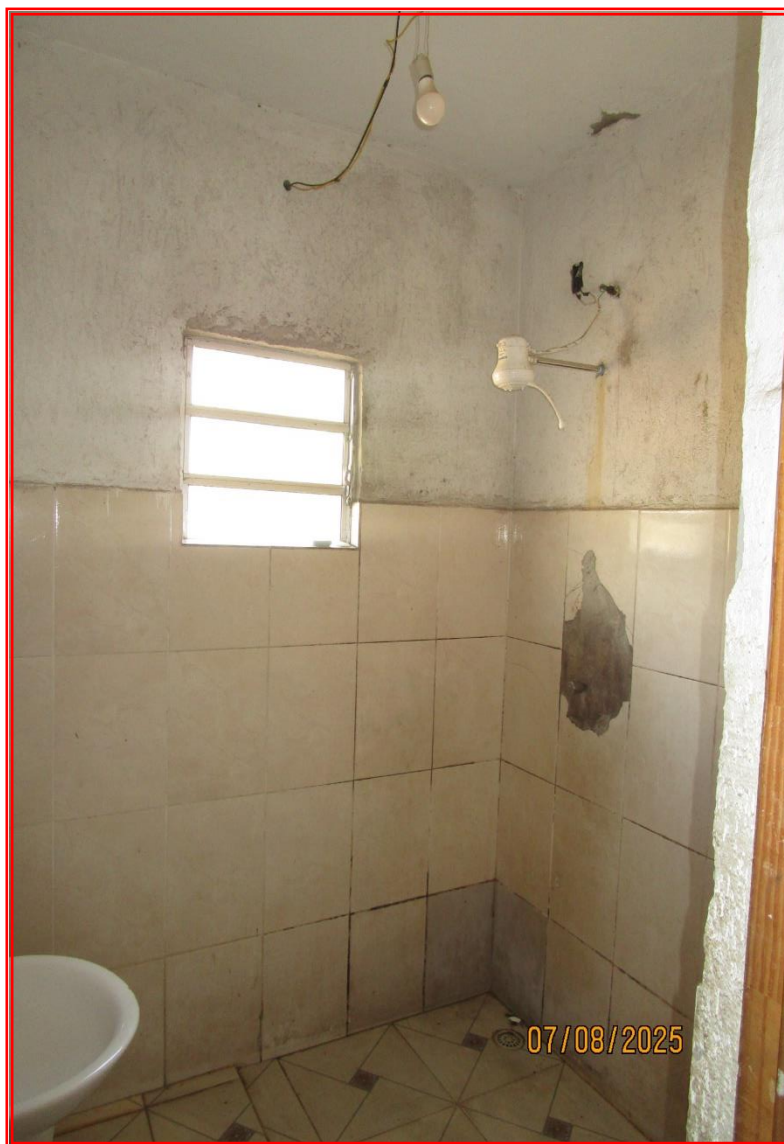
Foto nº 28: Vista parcial do banheiro.
