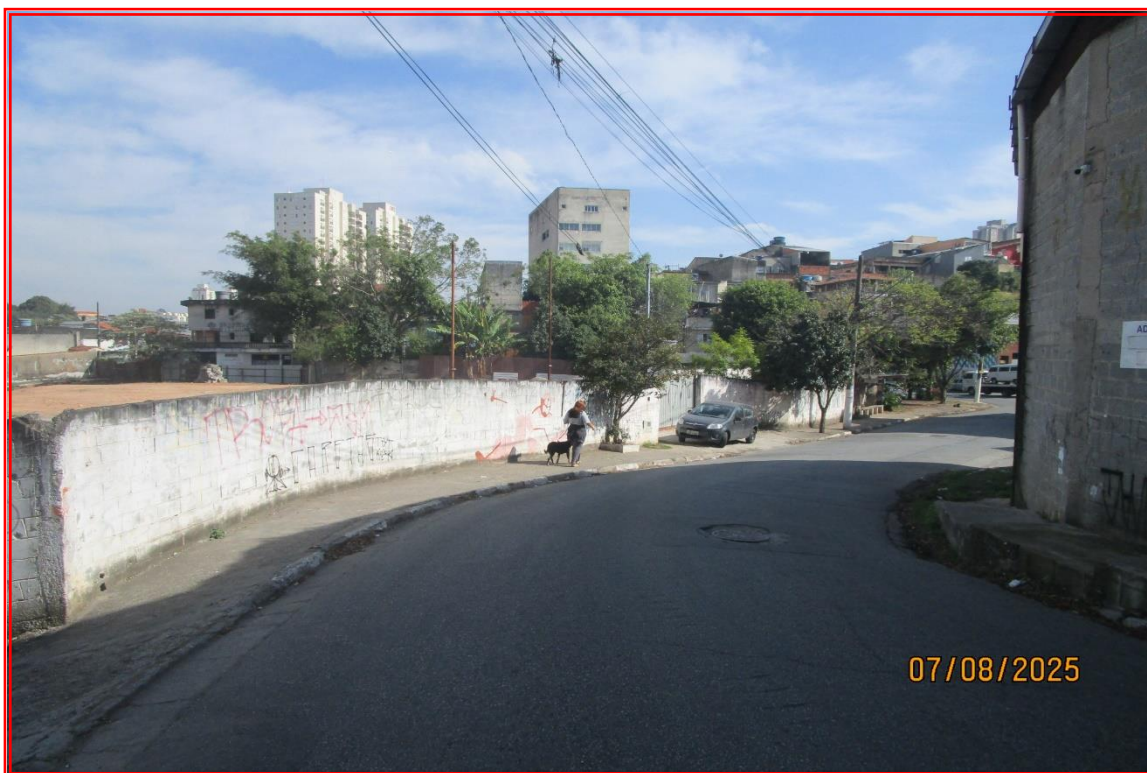
Foto: Vista parcial da Rua João Carlos Munhoz Vaqueiro, tomada no sentido oposto, onde se observa o imóvel avaliando, à esquerda.
