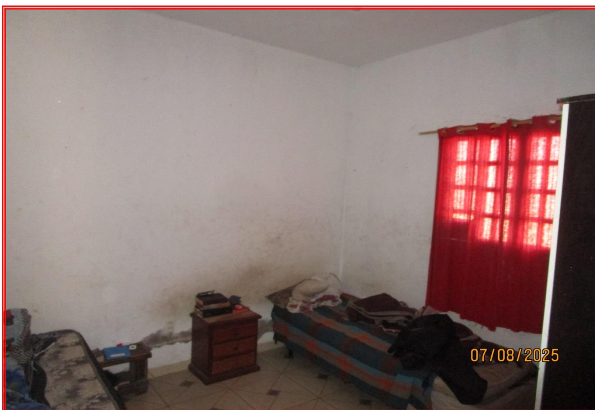
Foto nº 27: Vista parcial do dormitório.
