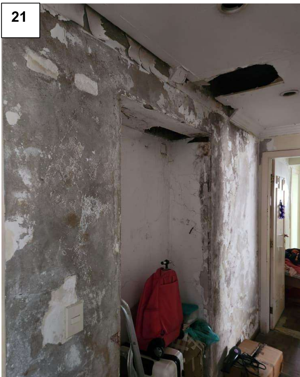
21 Corredor Acesso aos Quartos
