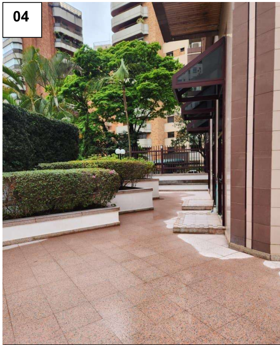
Corredor de Acesso
