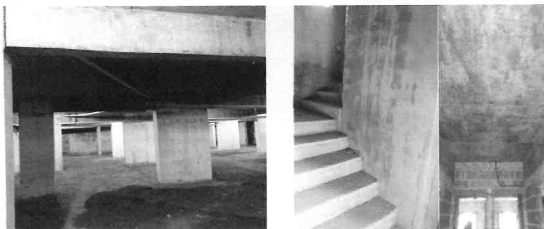
Foto 03 – Detalhe estrutural do edifício
