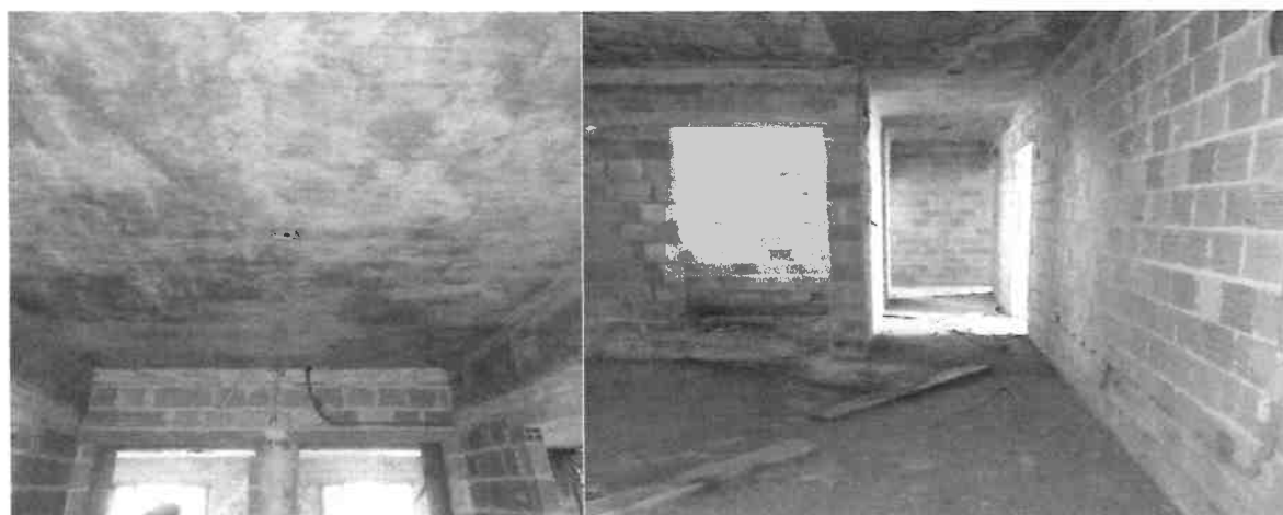
Foto 09 -Paredes e laje sem Reboco
