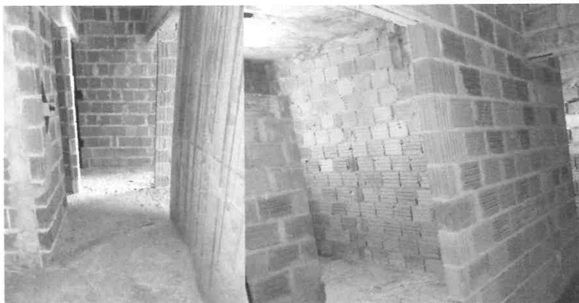
Foto 04 – Paredes em alvenaria
