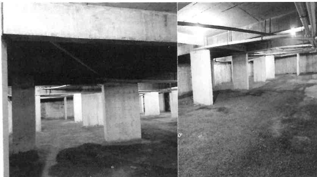
Foto 02 -Fotos da base do edifício – Posição dos pilares.
