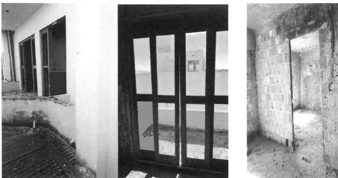
Foto 06 - Peças de esquadrias e vão a serem instalados.
