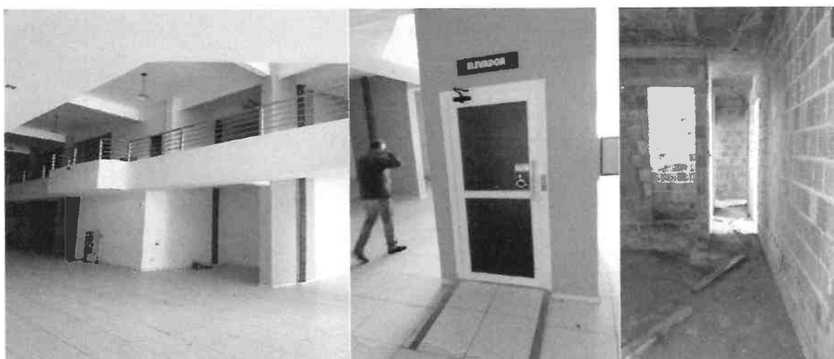
Foto 11 – Sistema preventivo de incêndio ( área comercial pronta/ residencial falta instalação.
