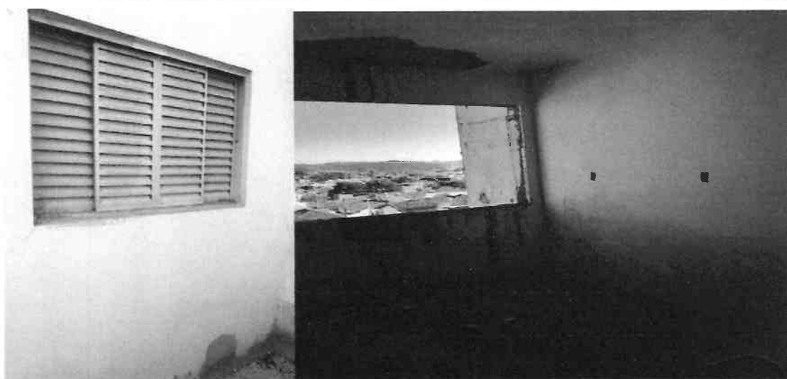
Foto 05 – Paredes em alvenaria rebocadas.
