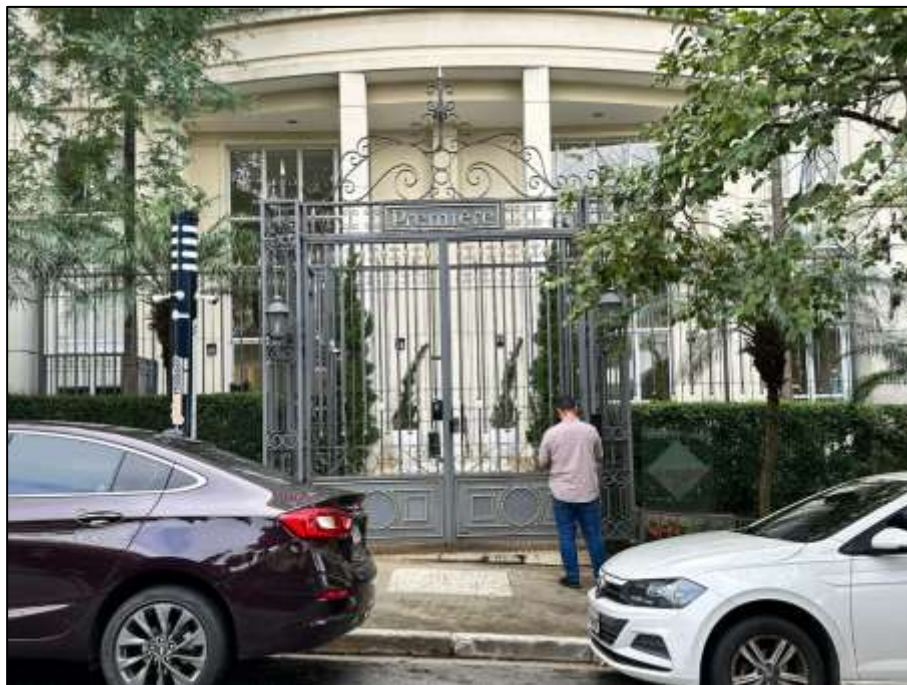
Aspectos gerais fachada e do acesso social.
