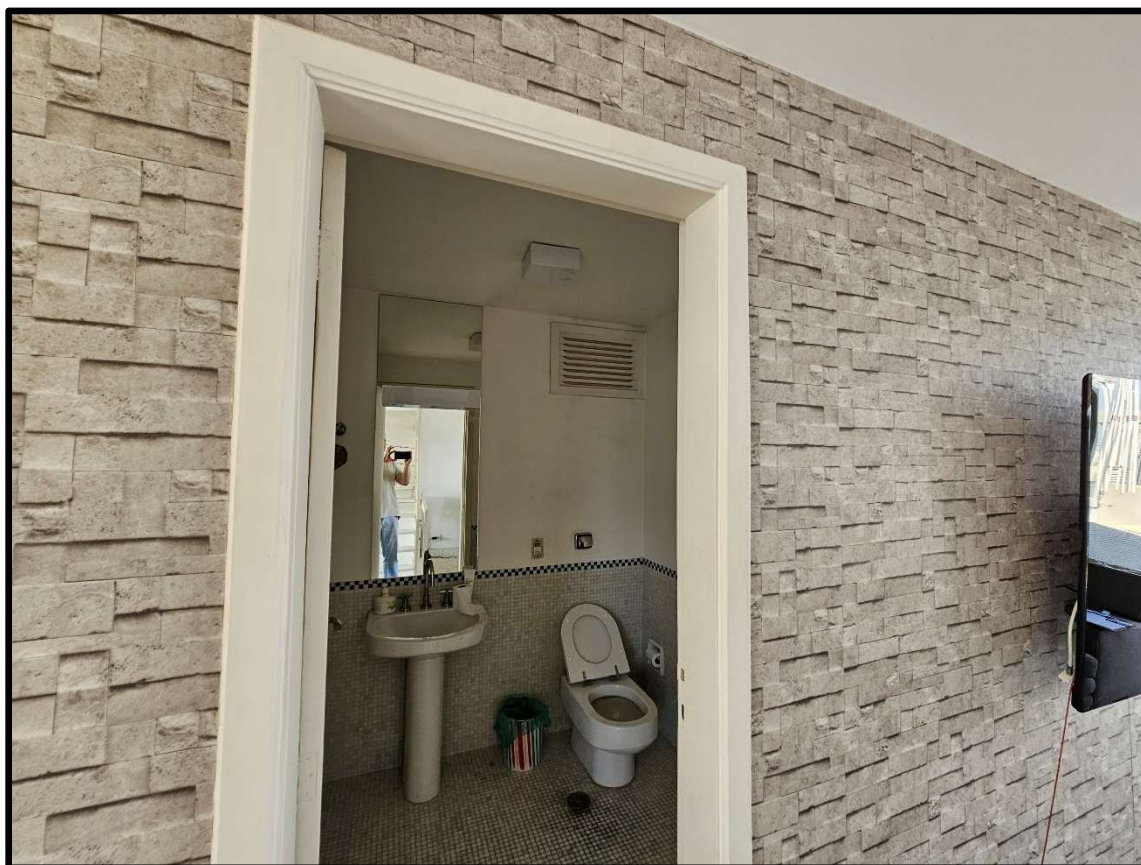
Figura 45: Lavabo (2º Pavimento)
