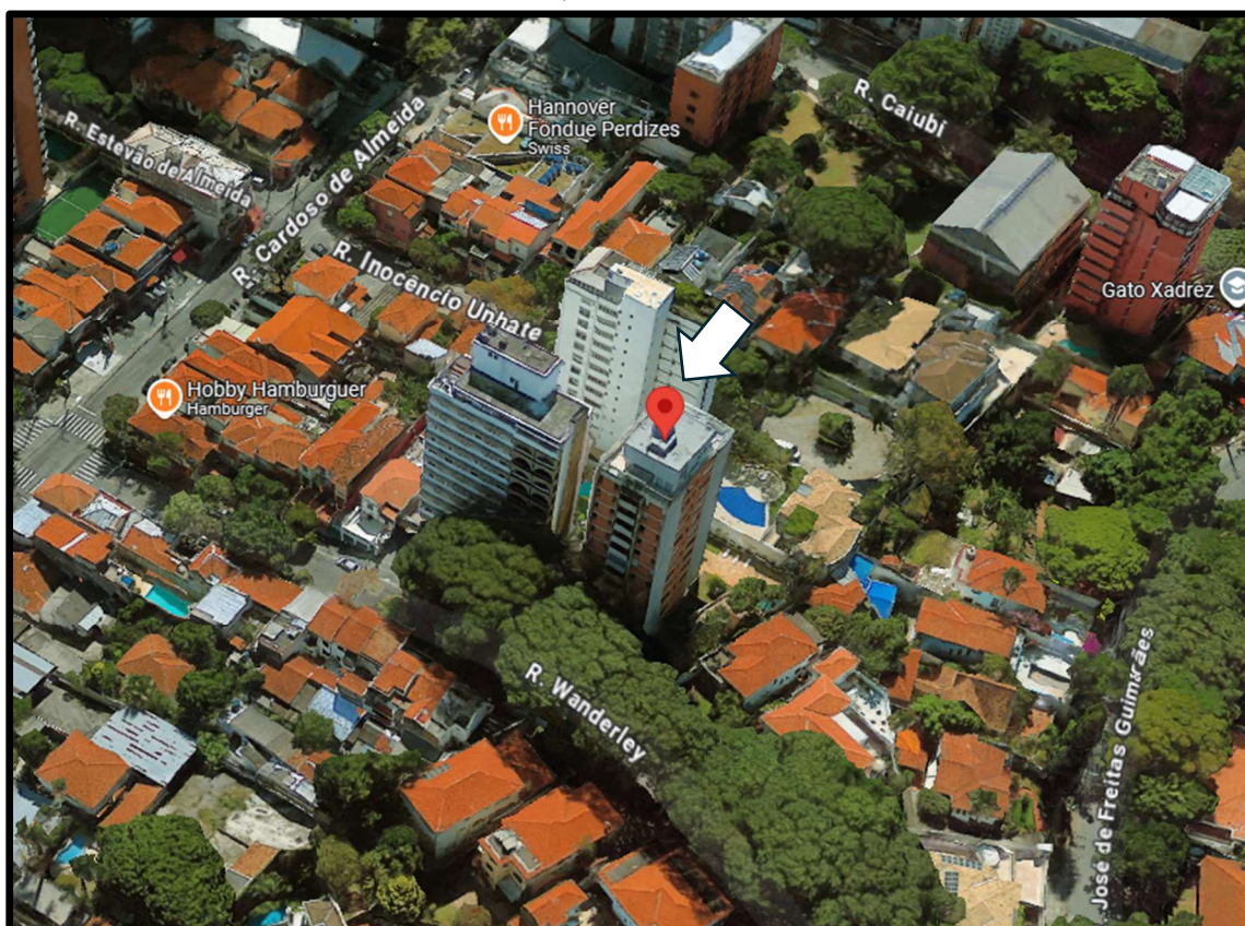
Figura 4: Vista aérea do imóvel
