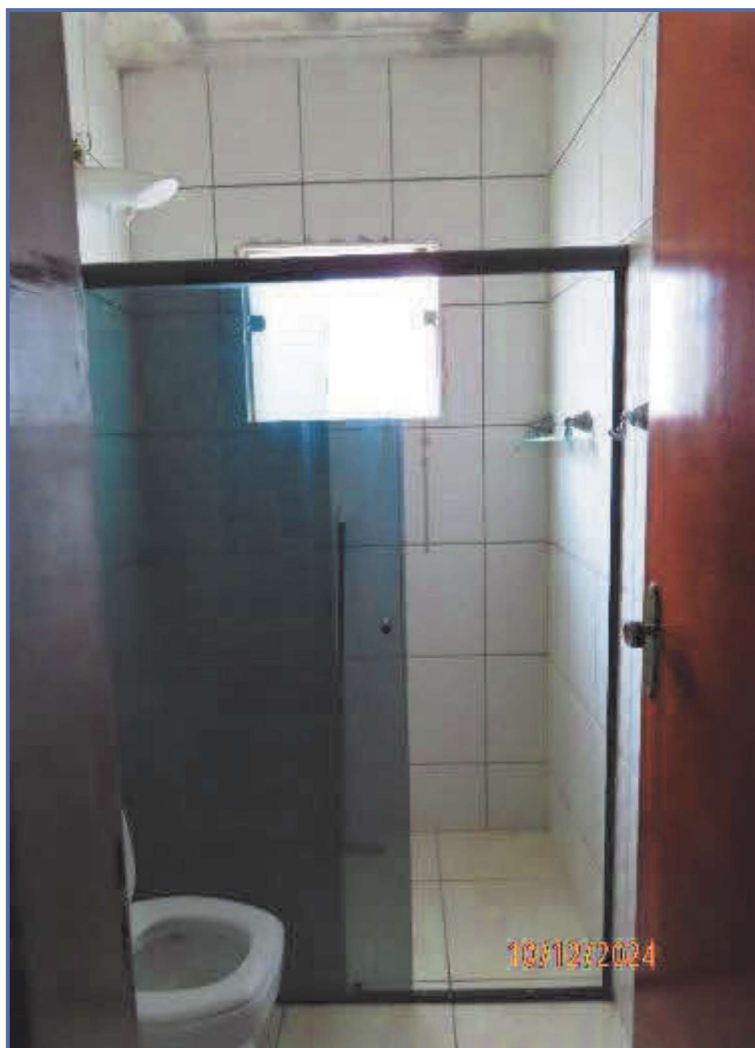
Foto n° 15: Vista parcial do banheiro.
