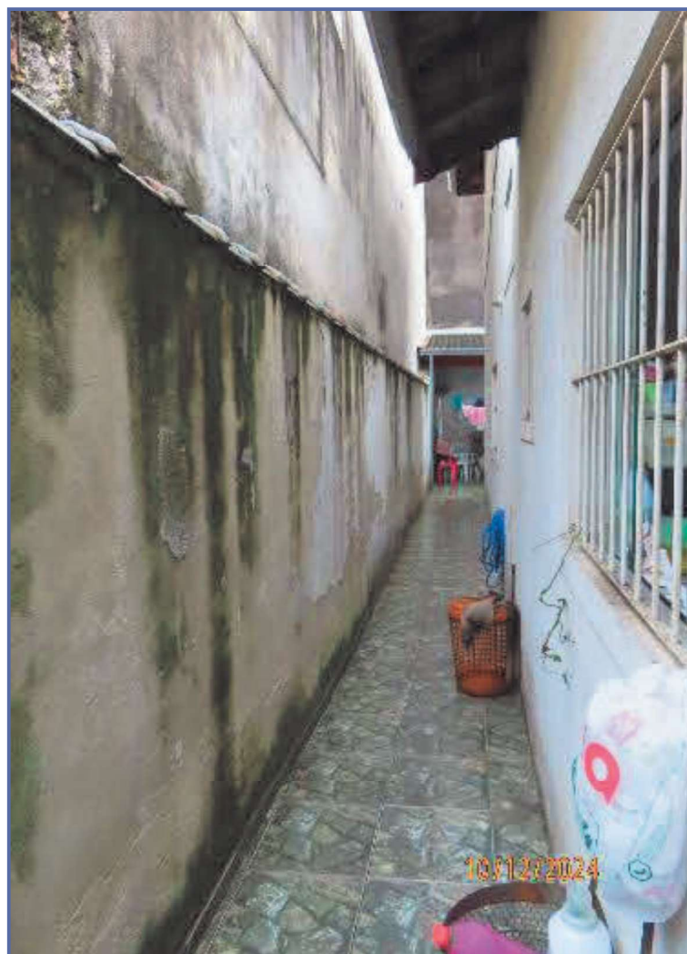
Foto nº 16: Vista parcial do corredor, com detalhe para a cobertura a párea de serviço coberta aos fundos.
