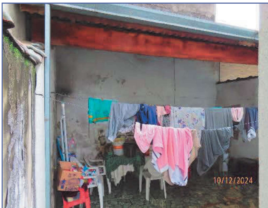
Foto nº 17: Vista parcial da área de serviço.
