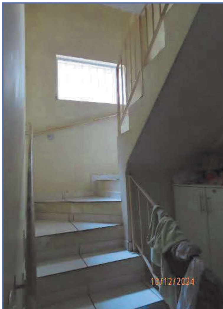
Foto nº 12: Vista da escada de acesso ao pavimento superior.
