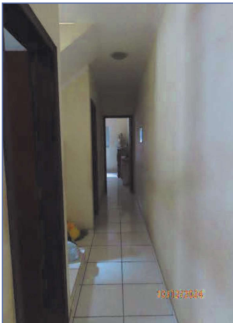
Foto nº 8: Vista parcial do corredor de circulação.
