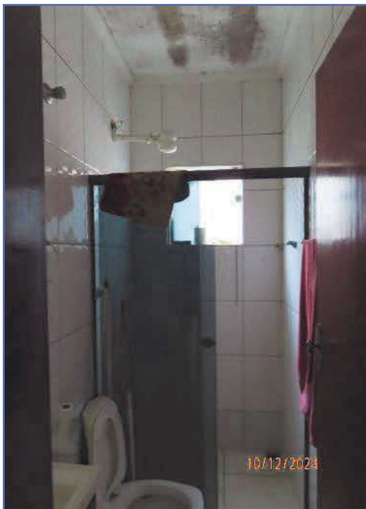
Foto n° 9: Vista parcial do banheiro.
