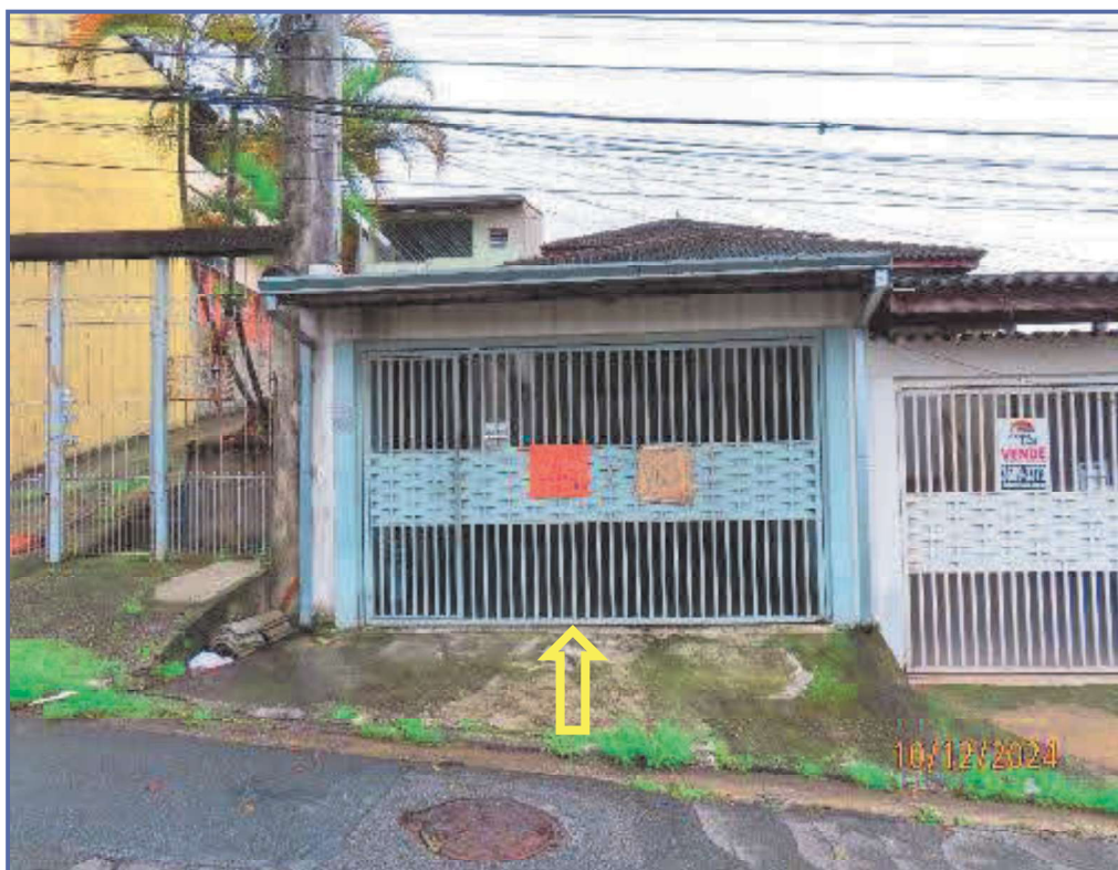
Foto nº 1: Vista geral da fachada do imóvel avaliando
