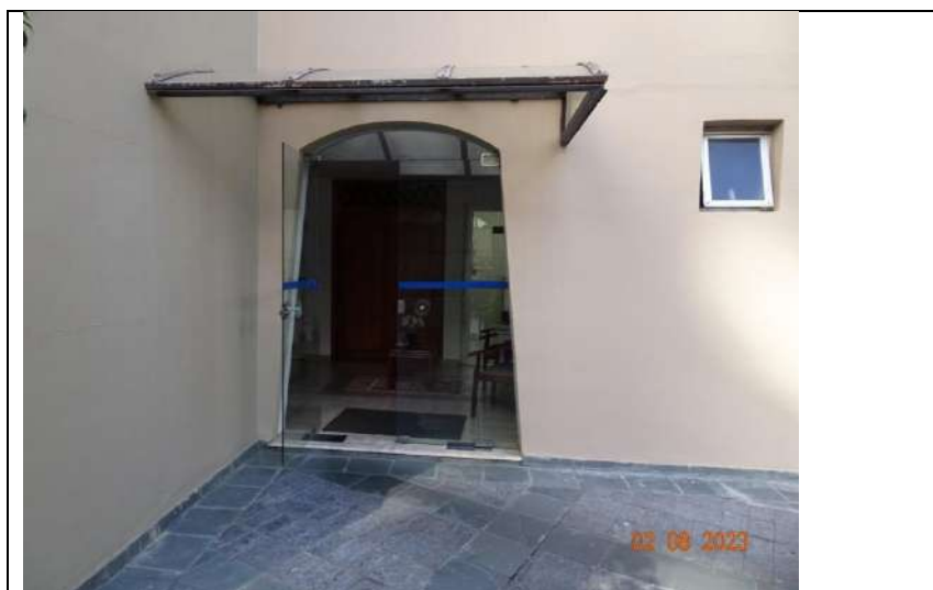
Foto 12. Vista da porta de entrada de acesso ao hall do Edifício San Marino.
