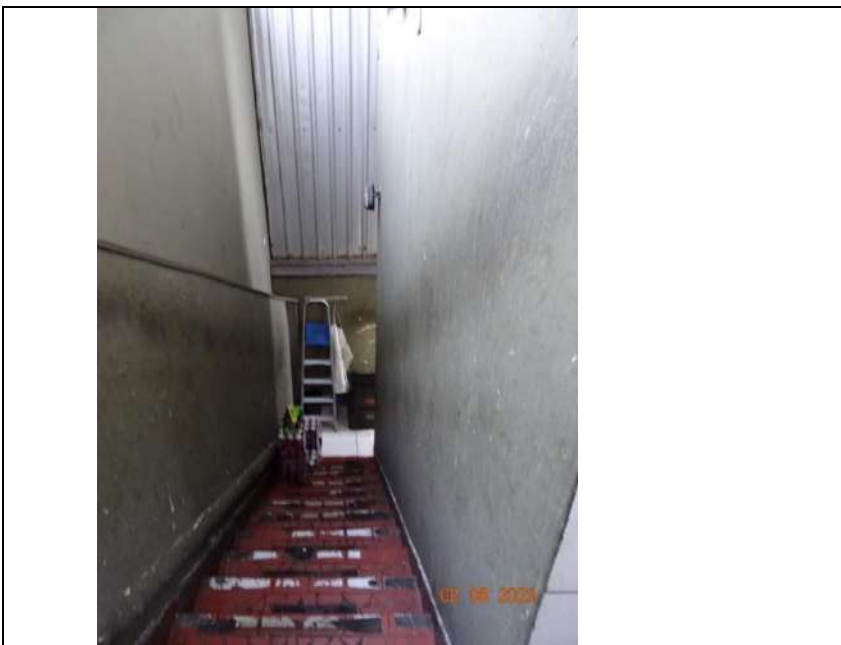
Foto 42. Vista da escada externa de circulação de acesso ao pavimento térreo.
