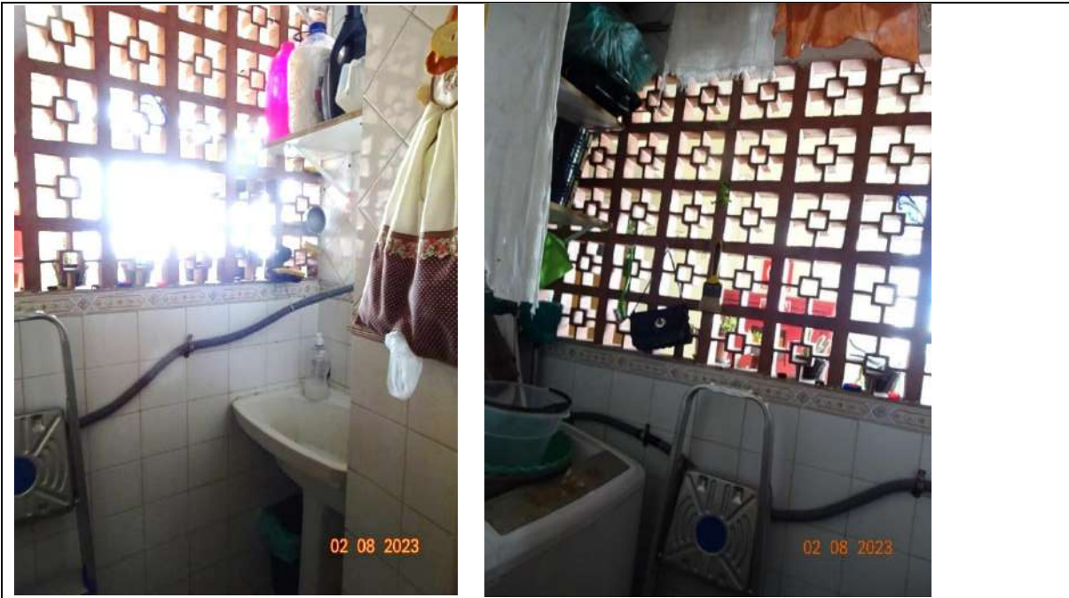
Foto 40. Vista da lavanderia da unidade avalianda.
