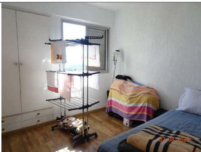
Foto 32. Vista do dormitório 02. Note piso em carpete de madeira e janela em alumínio.
