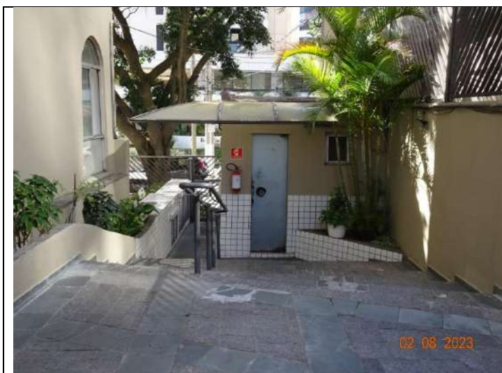
Foto 7. Vista da portaria de entrada do "Edifício San Marino".
