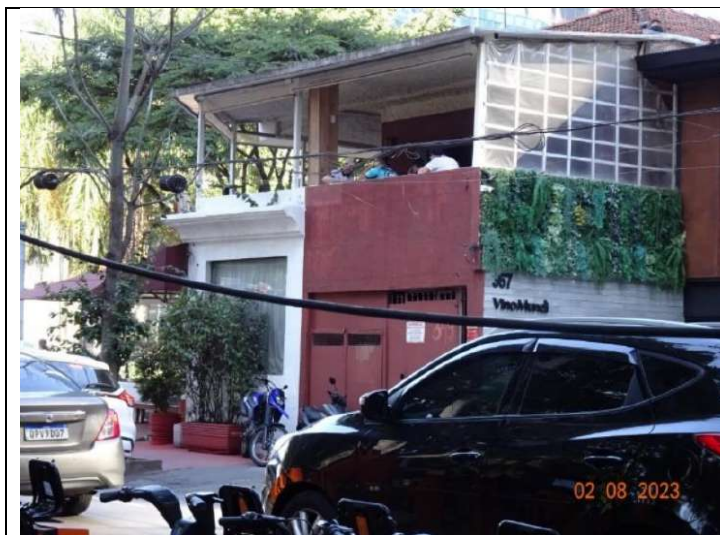
Foto 1. Vista parcial da fachada do imóvel na Rua Ministro Jesuíno Cardoso
