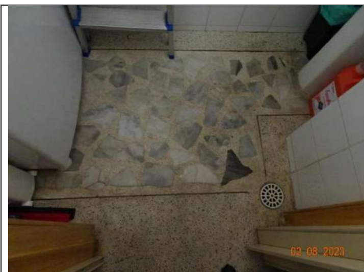
Foto 42. Vista do piso da lavanderia.
