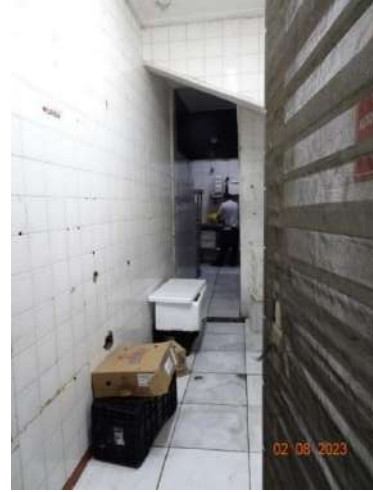
Foto 20. Vista do corredor de acesso a cozinha, com deficiências no revestimento de paredes.
