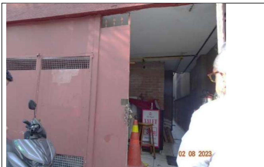
Foto 45. Vista a partir da rua, mostrando a área de acesso ao corredor de circulação externo.
