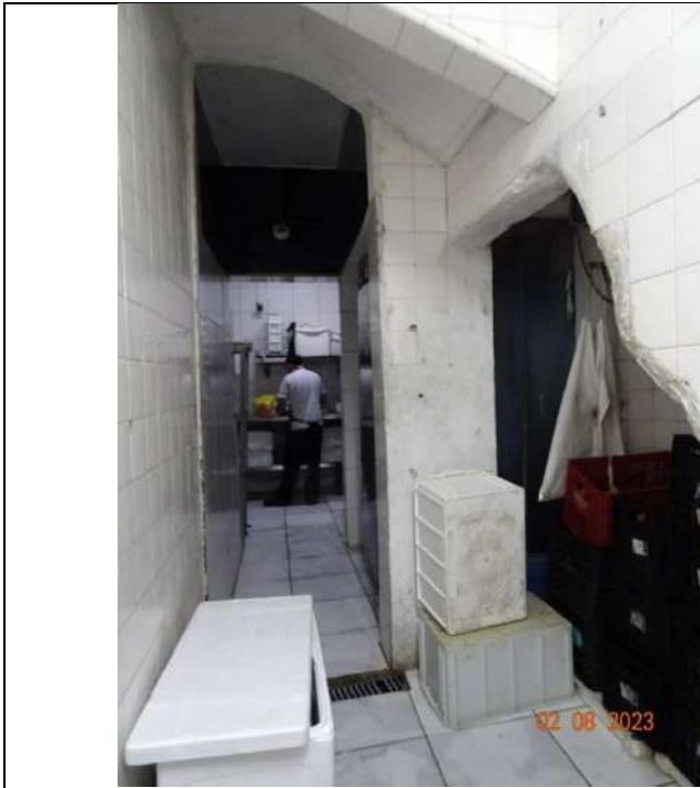
Foto 20. Vista do corredor de acesso a cozinha, com deficiências no revestimento de paredes.
