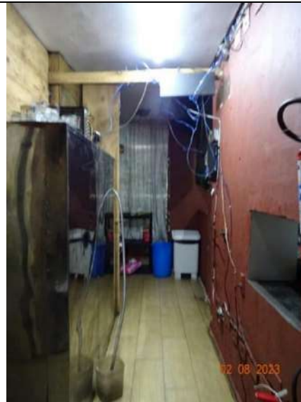
Foto 26. Vista da fiação exposta, A área necessita de reformas nas instalações elétricas.
