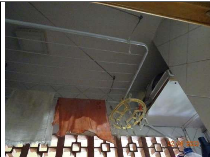
Foto 41. Vista do teto da lavanderia.
