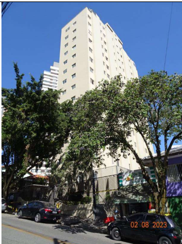
Foto 1. Vista das fachadas frontal e lateral do Edifício San Marino
