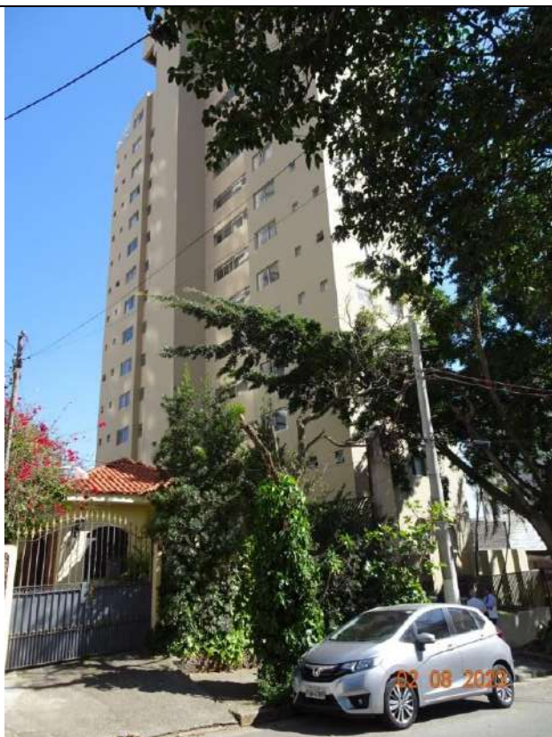
Foto 2. Vista parcial da fachada lateral do Edifício San Marino
