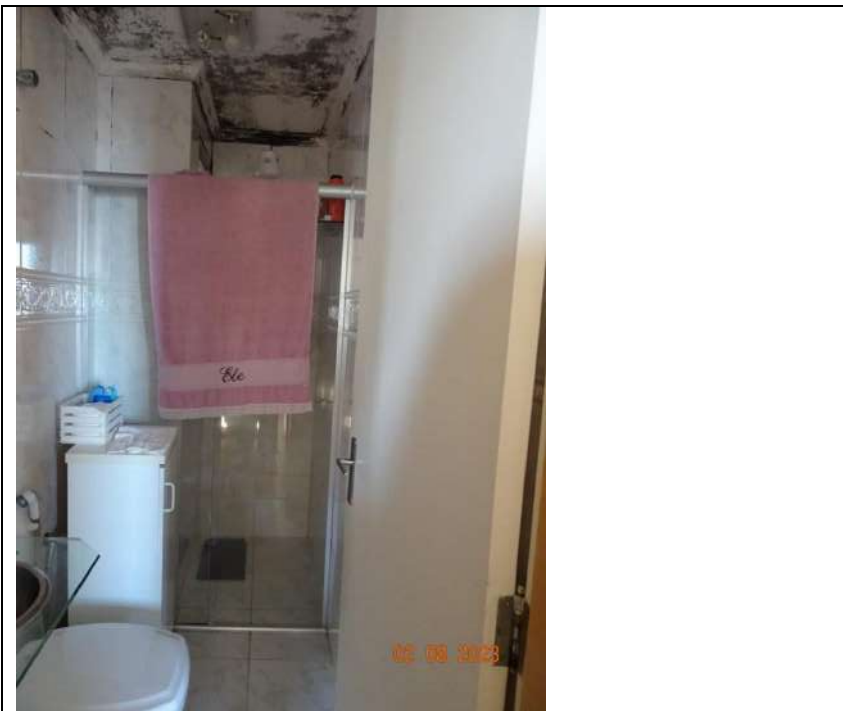
Foto 35. Vista do banheiro social
