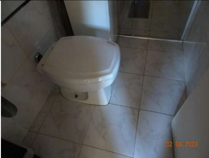
Foto 36. Vista do banheiro social, mostrando o piso cerâmico.
