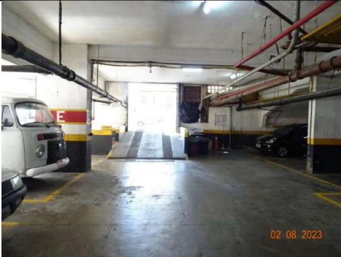
Foto 16. Vista parcial do subsolo.
