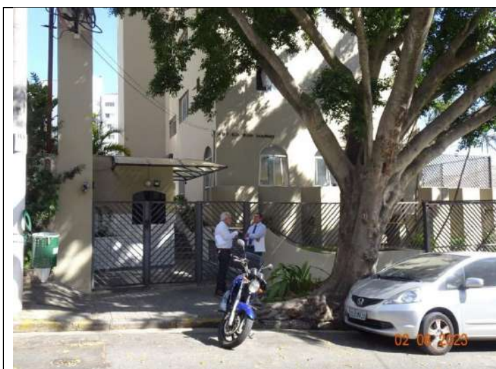
Foto 5. Vista da portaria e do portão de acesso de pedestres.
