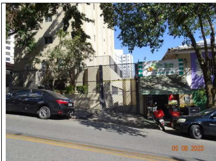
Foto 8. Vista do portão de acesso de veículos.
