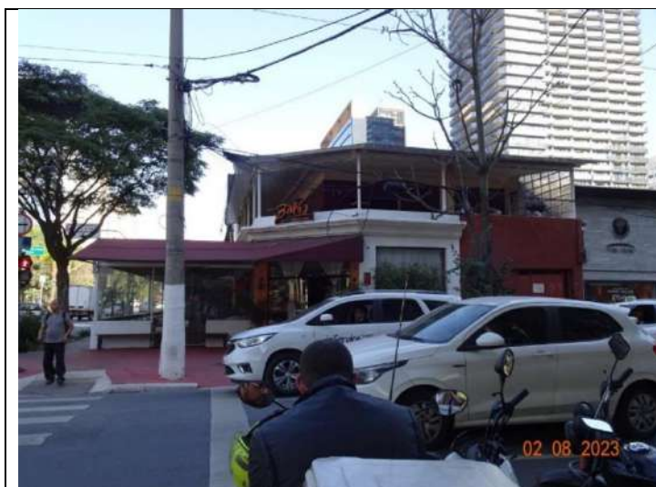
Foto 2. Vista parcial da fachada do imóvel na Rua Ministro Jesuíno Cardoso
