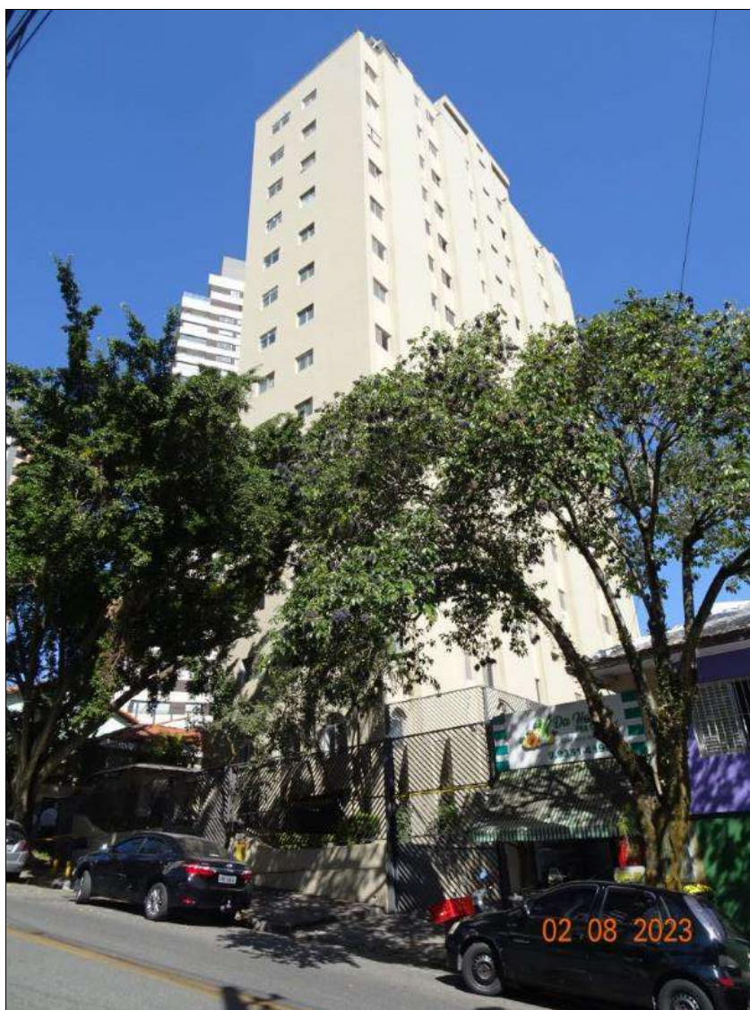
Foto 1. Vista da fachada do "Edifício San Marino".
