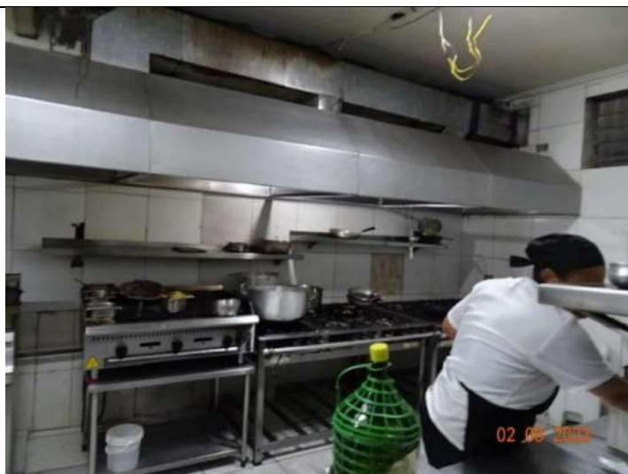
Foto 13. Vista parcial da cozinha
