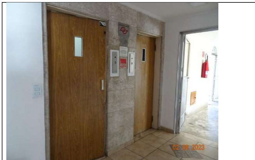
Foto 13. Vista do hall de elevadores do edificio San Marino
