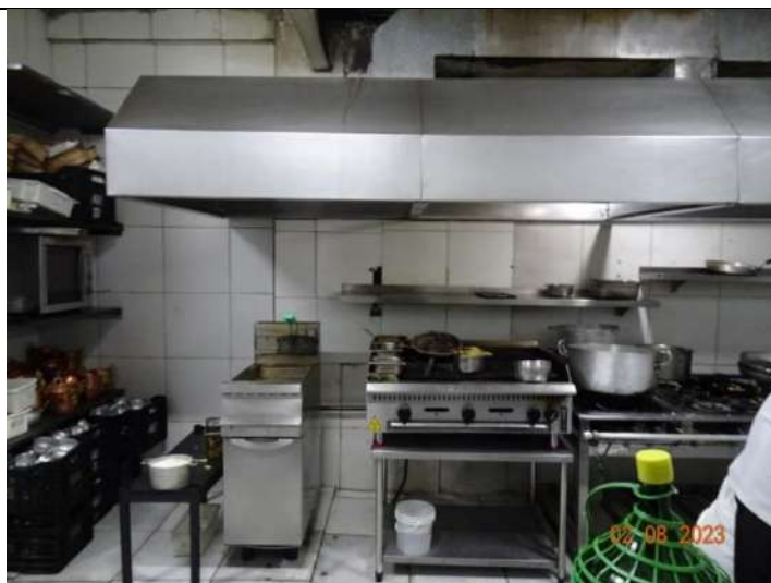
Foto 12. Cozinha – piso cerâmico e paredes com revestimento cerâmico até o teto
