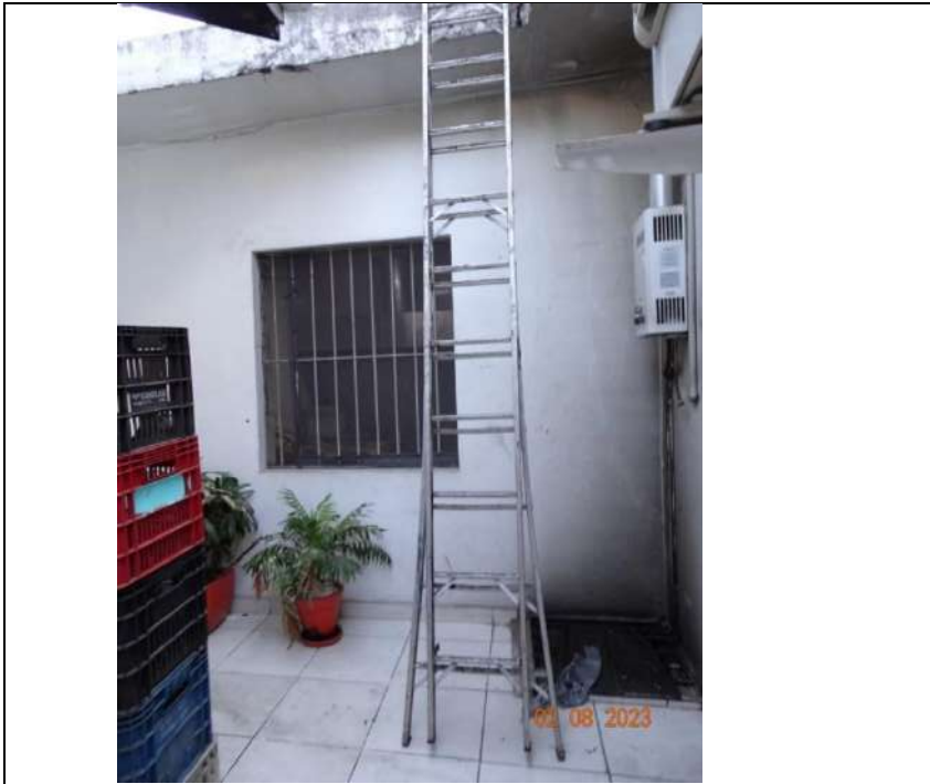
Foto 39. Vista da área externa do pavimento superior – piso cerâmico
