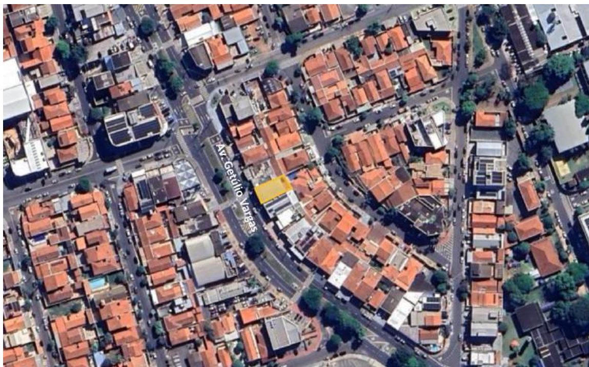
Imagem 10 – Localização do imóvel na Rua Getúlio Vargas, 613 – Bairro Nova Paulínia – Paulínia/SP. Fontes: Google Earth
