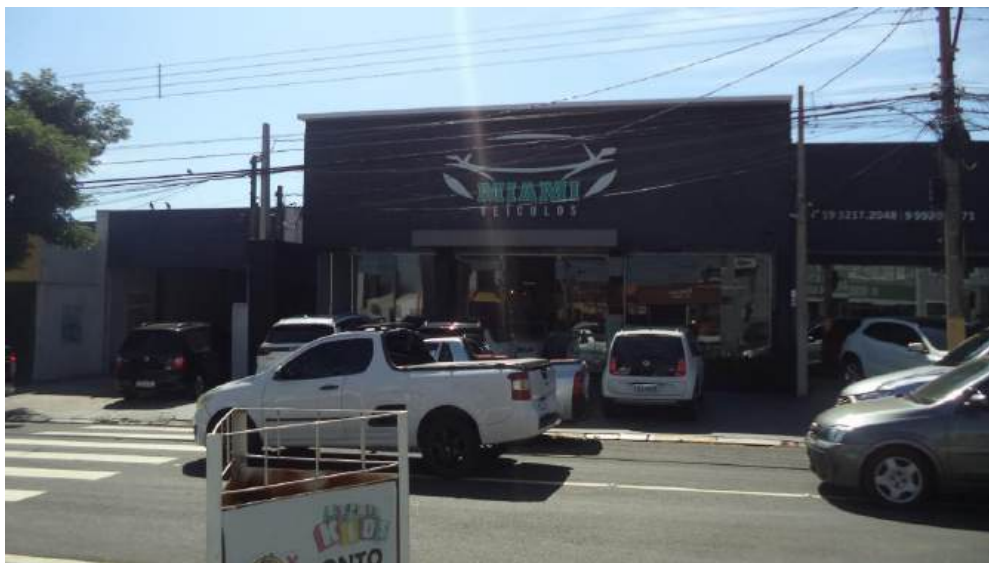
Foto 17 – Vista da fachada do galpão localizado na Rua Getúlio Vargas, 613
