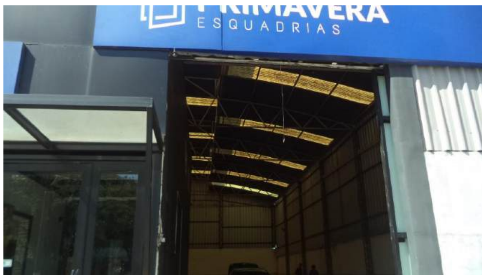
Foto 28 – Vista da parte interna do galpão
