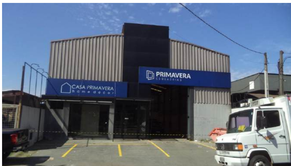
Foto 27 - Vista da fachada do galpão localizado na Av. José Lozano Araújo, 1253
