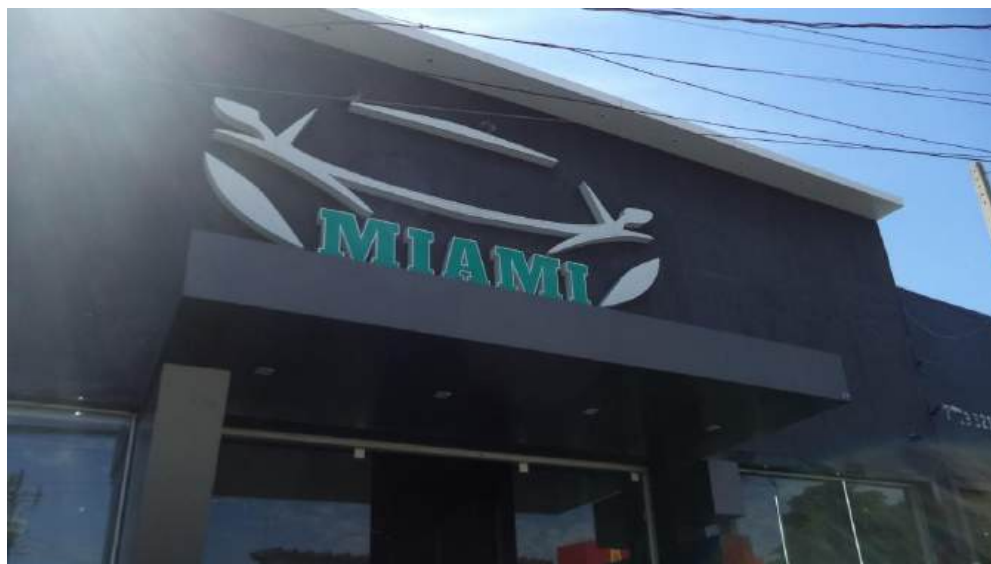
Foto 19 - Vista da fachada do galpão localizado na Rua Getúlio Vargas, 613
