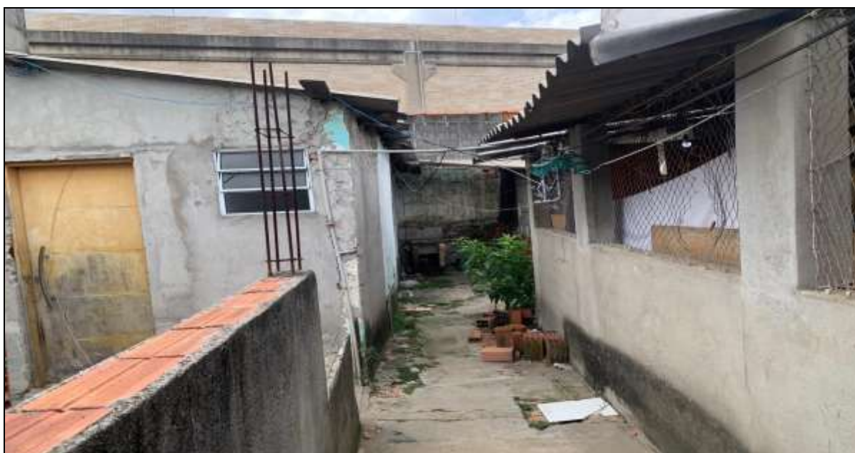
Foto 10 – Vista do corredor externo.
