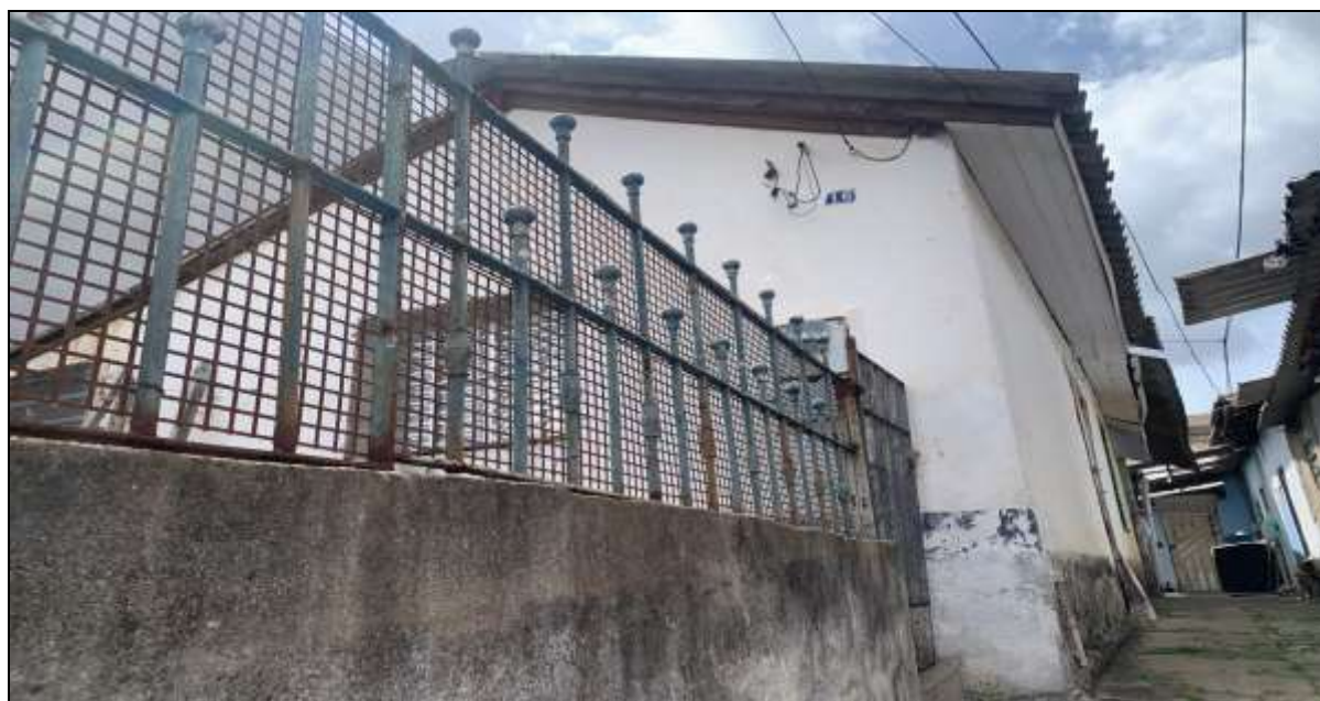
Foto 2 – Vista da fachada.
