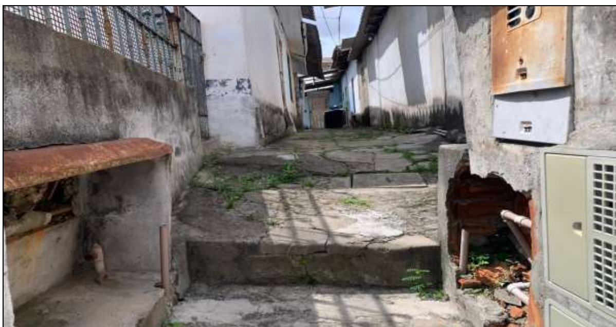
Foto 4 – Vista do acesso ao imóvel.
