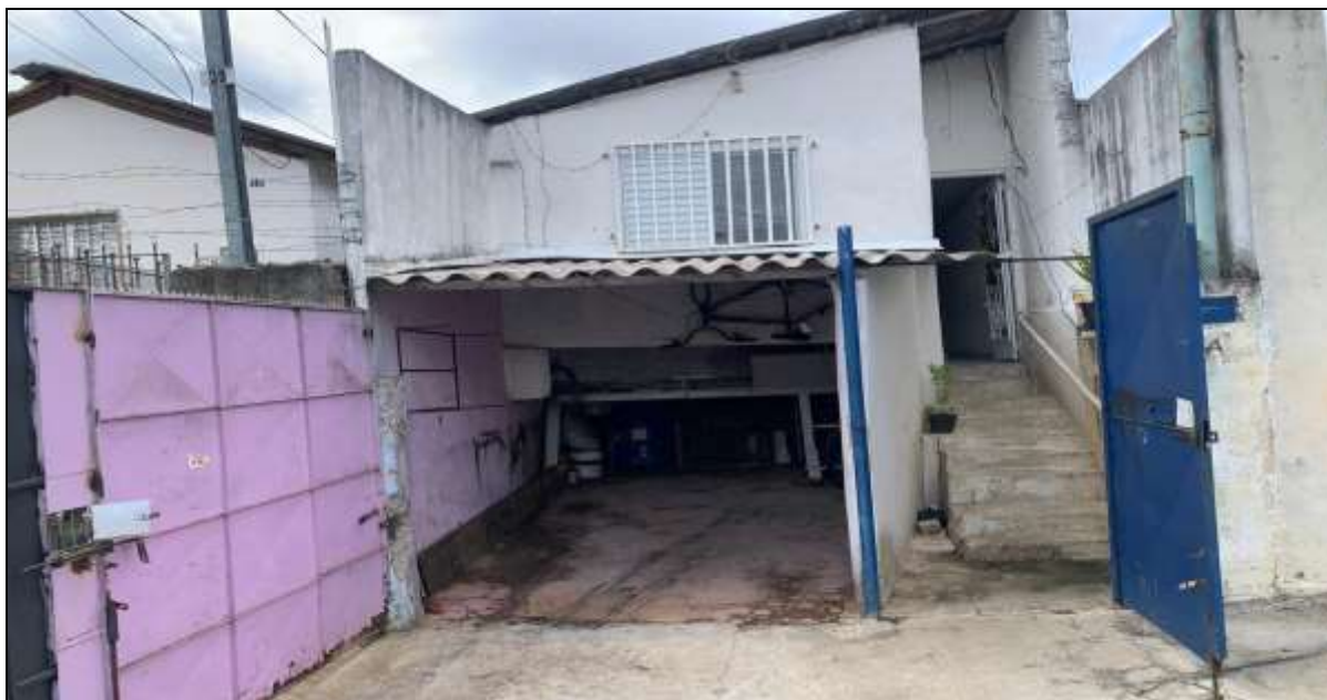
Foto 17 – Vista da fachada.
