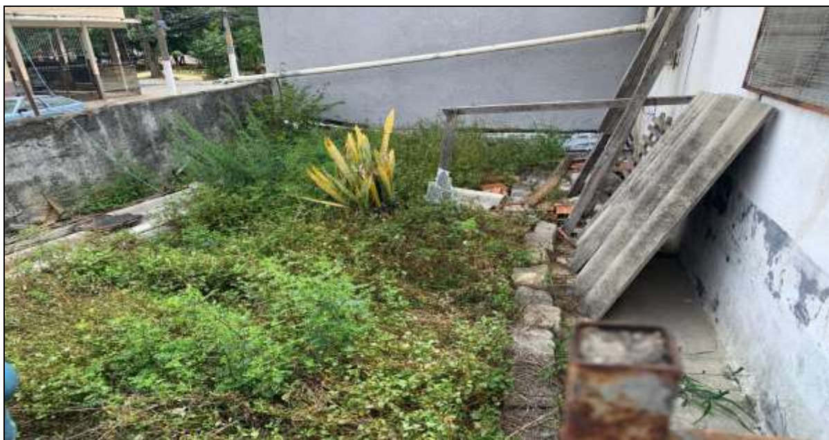
Foto 3 – Vista da área frontal do imóvel.
