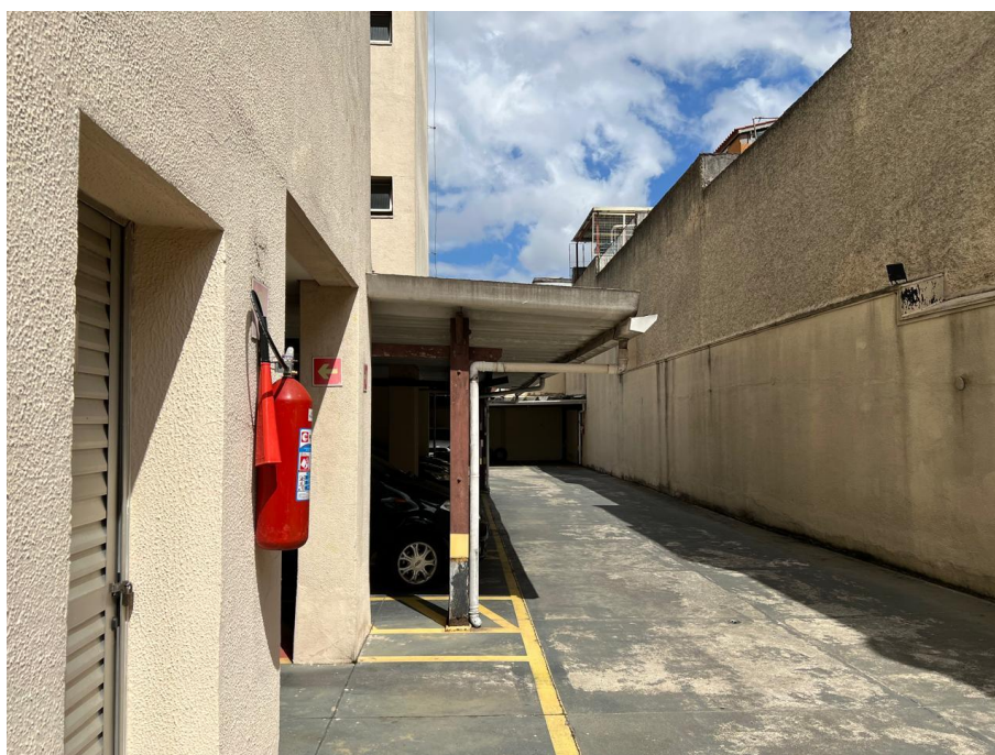
Vista do acesso aos fundos e garagem
