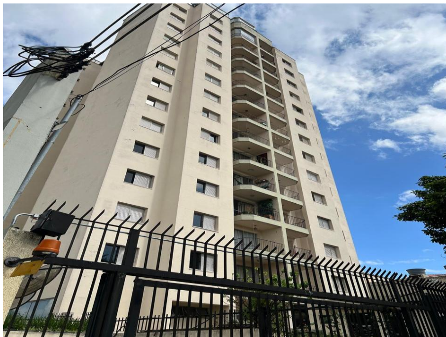
Vista da fachada do Edifício
