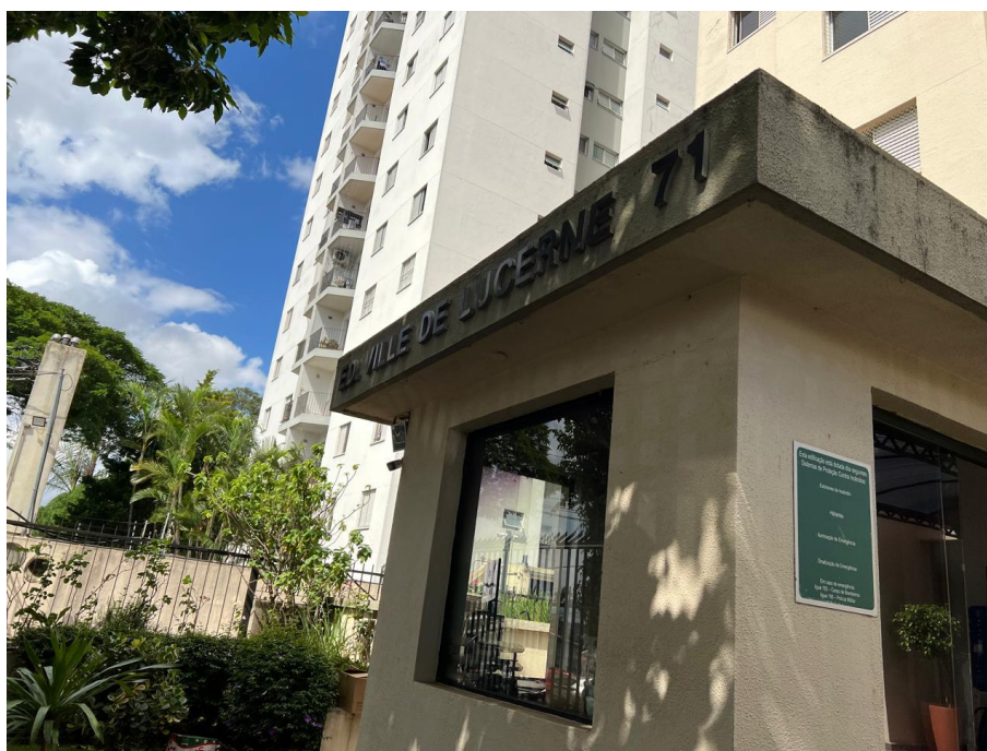
Vista da portaria do Edifício
