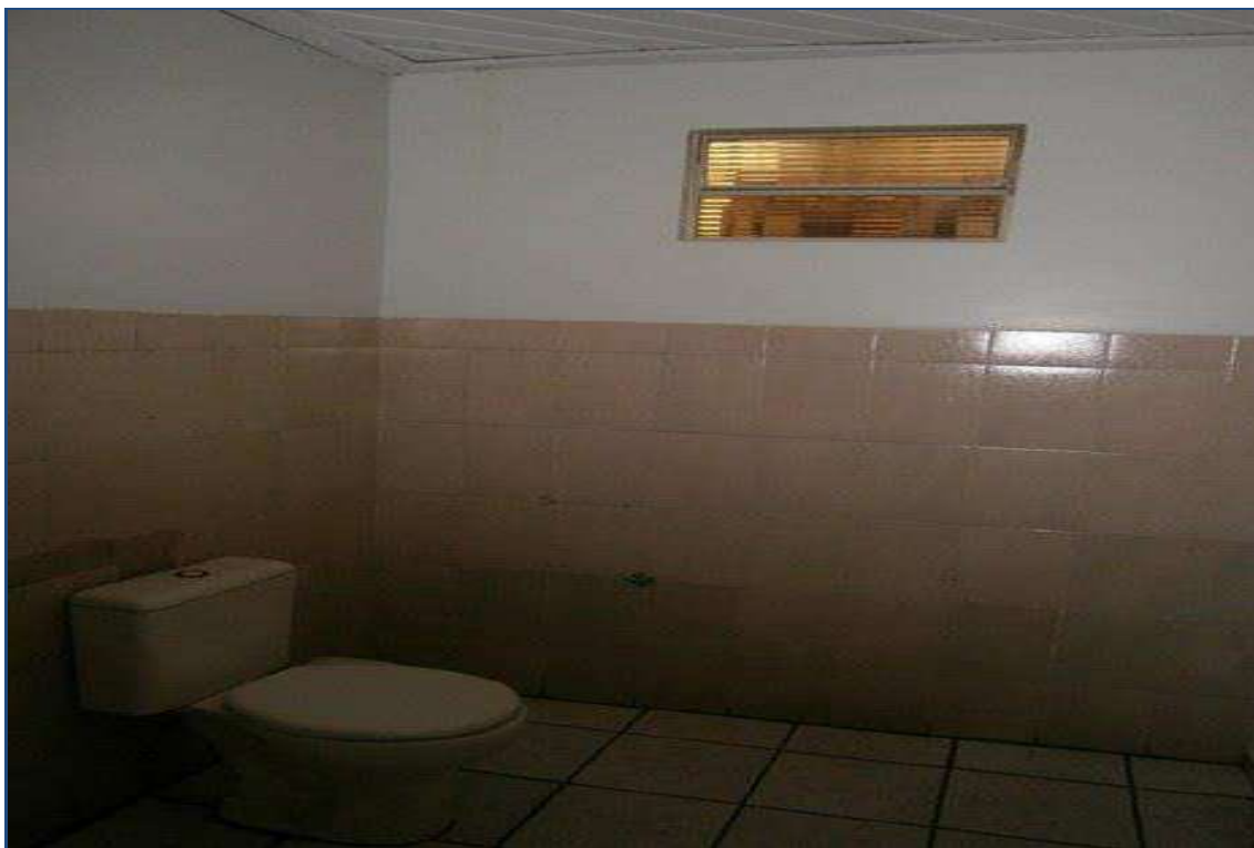
FOTO nº 10 Vista do sanitário masculino na parte frontal do imóvel avaliando.
