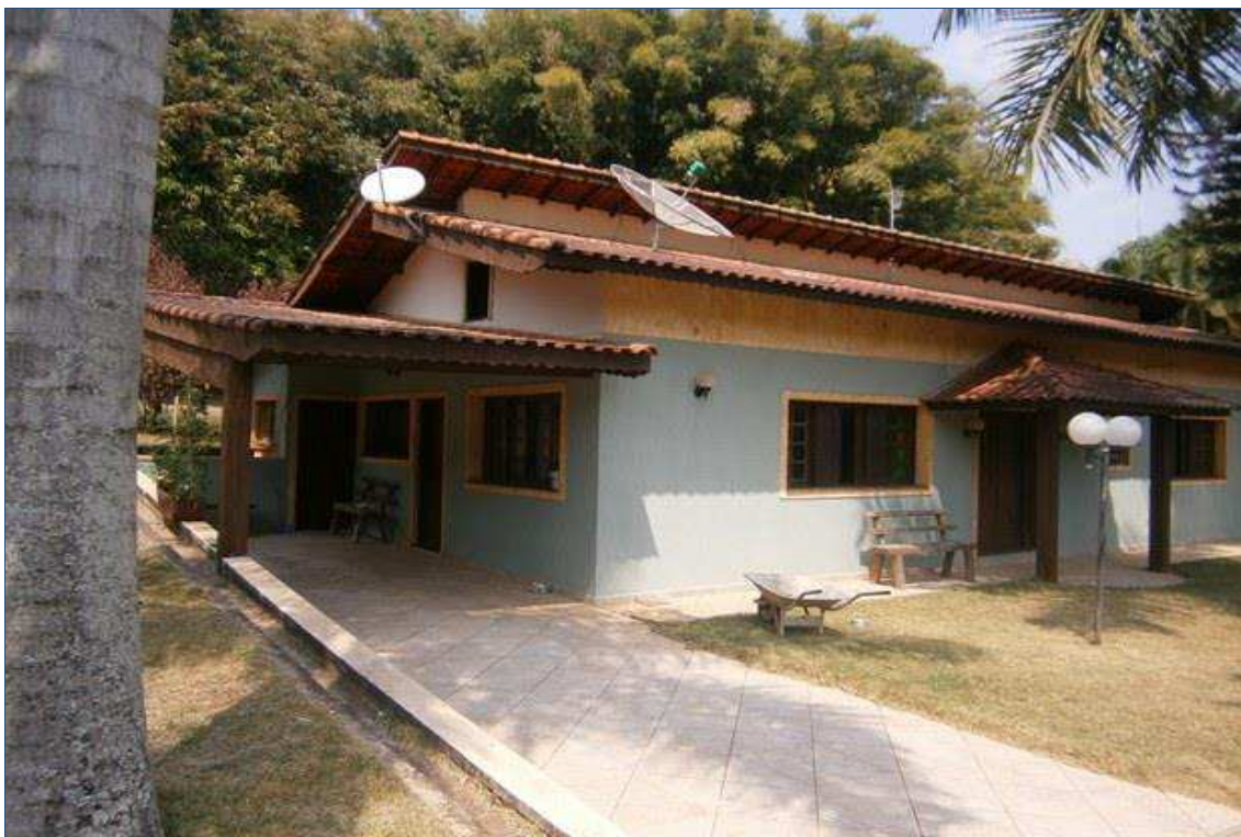
FOTO nº 35 Vista da Casa Periférica.
