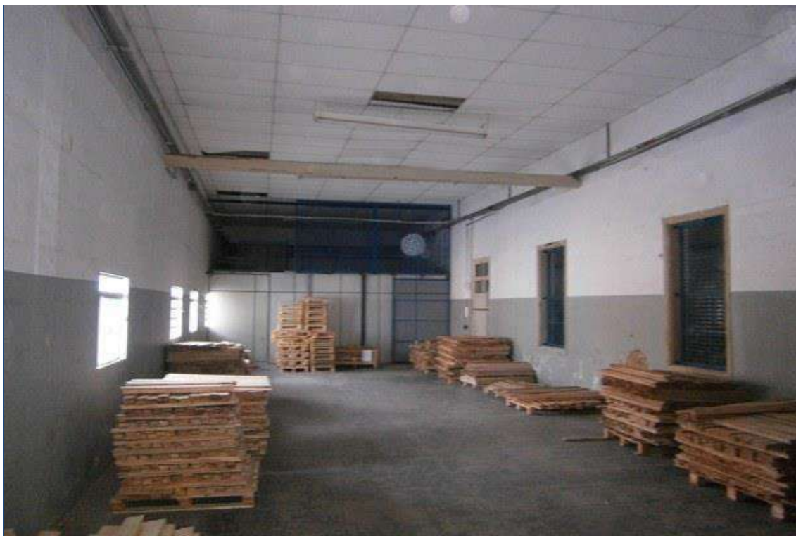
FOTO nº 18 Vista da área periférica do Galpão.
