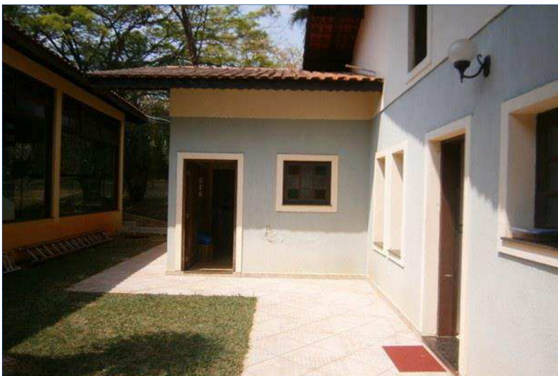
FOTO nº 05 Vista dos acessos à Casa Térrea Principal.
