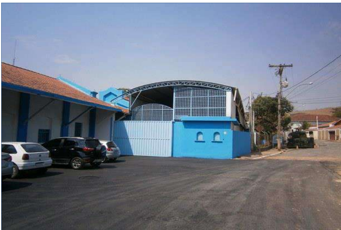
FOTO nº 03 Vista da fachada frontal do imóvel avaliando.
