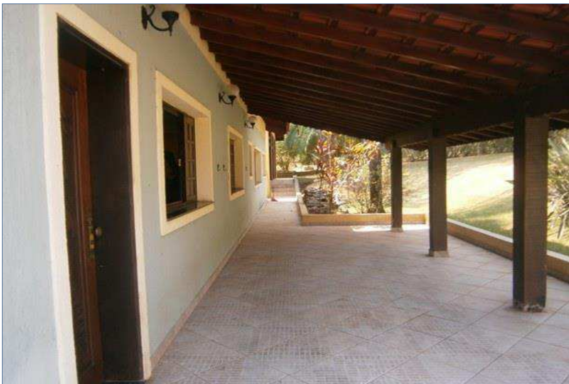
FOTO nº 03 Vista da área externa à Casa Térrea Principal.
