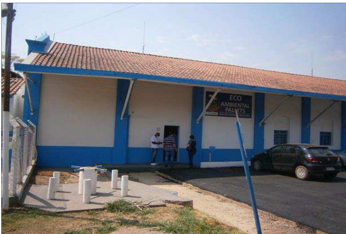
FOTO nº 05 Vista da fachada frontal do imóvel avaliando.
