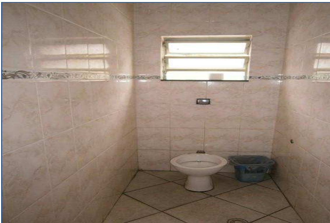
FOTO nº 18 Vista do w.c no nível superior ao piso do galpão.
