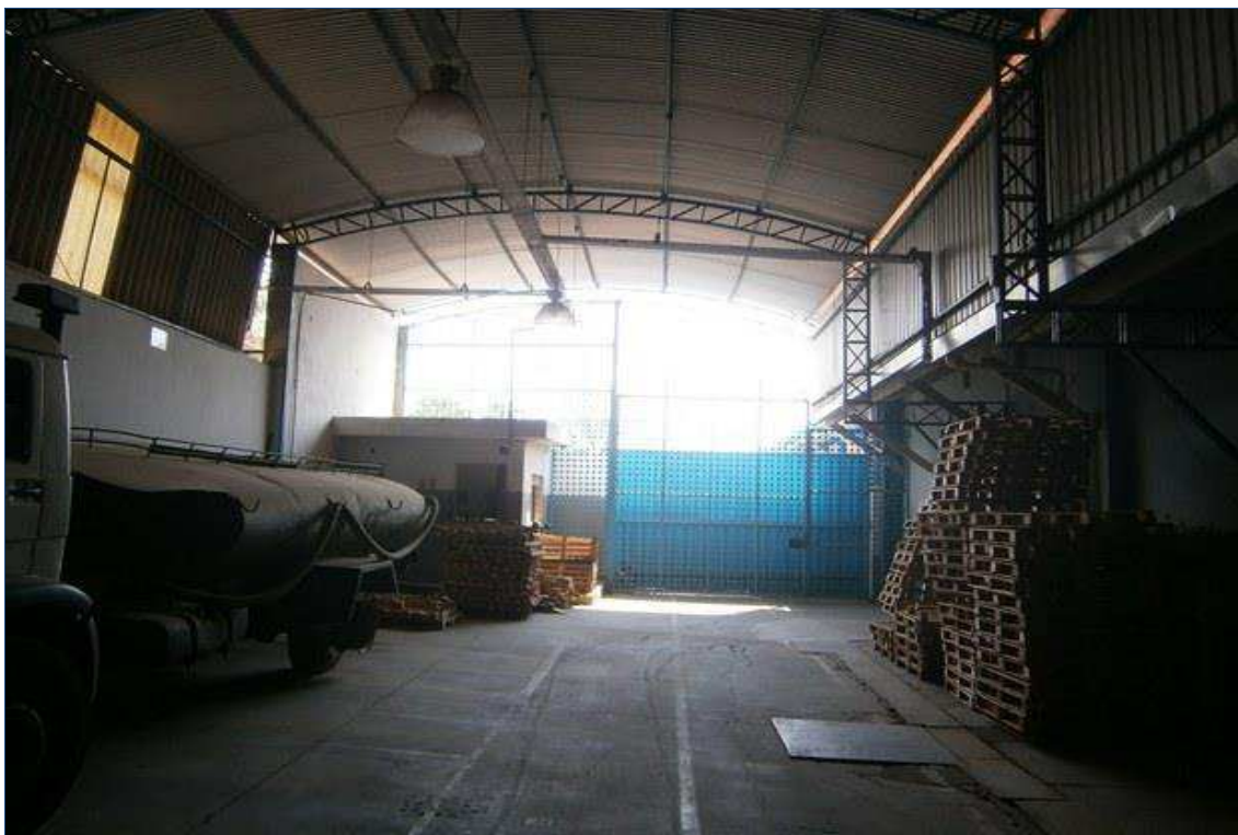
FOTO nº 23 Vista do Galpão.
