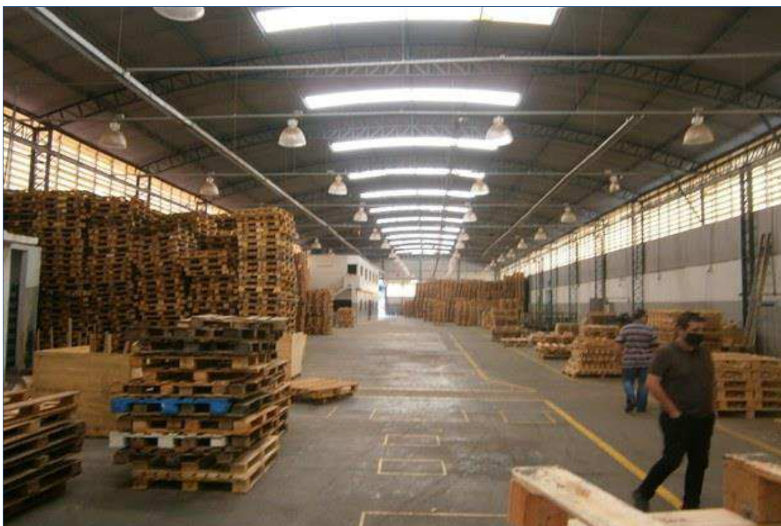
FOTO nº 27 Vista do Galpão.
