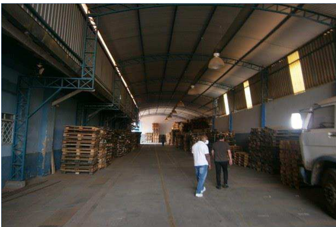
FOTO nº 22 Vista do Galpão.
