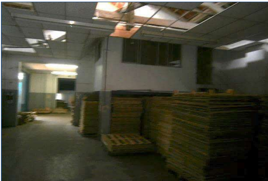
FOTO nº 20 Vista da área periférica do Galpão com Escritórios em pavimentos distintos.
