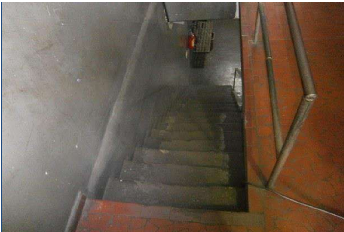
FOTO nº 21 Vista da escadaria entre os pavimentos térreo e inferior.
