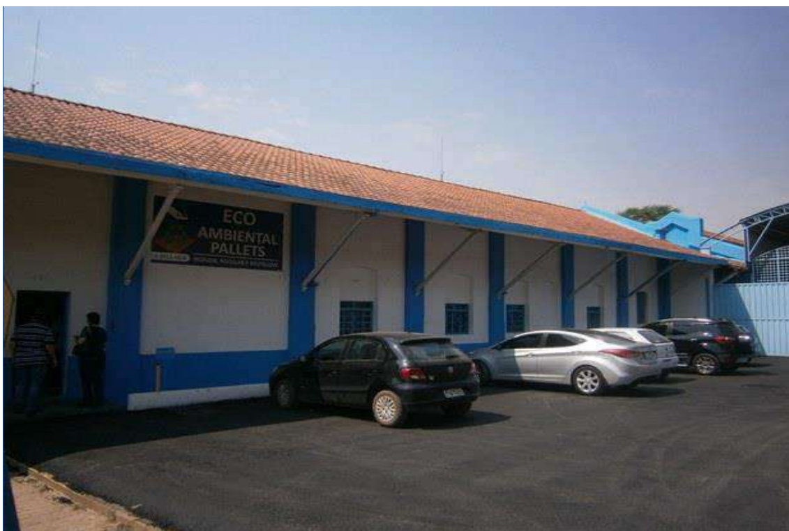
FOTO nº 04 Vista da fachada frontal do imóvel avaliando.
