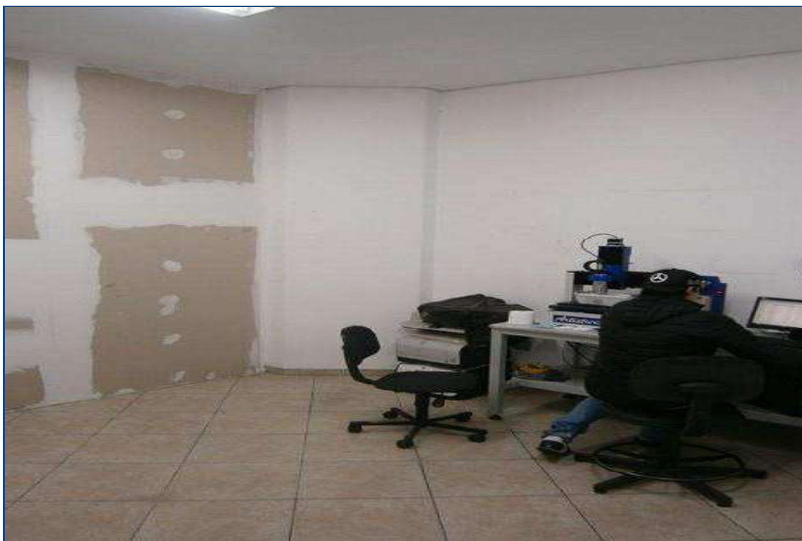
FOTO nº 12 Outra vista do escritório nivelado com o pavimento térreo do galpão.
