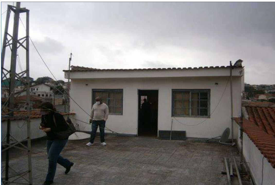
FOTO nº 17 Vista da área de cobertura coberta e o acesso ao terraço.
