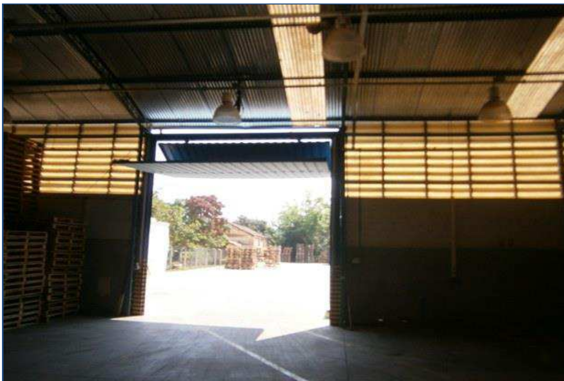
FOTO nº 13 Vista do Galpão e área adjacente aos fundos.
