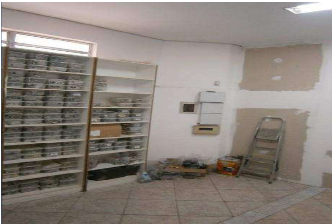
FOTO nº 11 Vista do escritório nivelado com o pavimento térreo do galpão.
