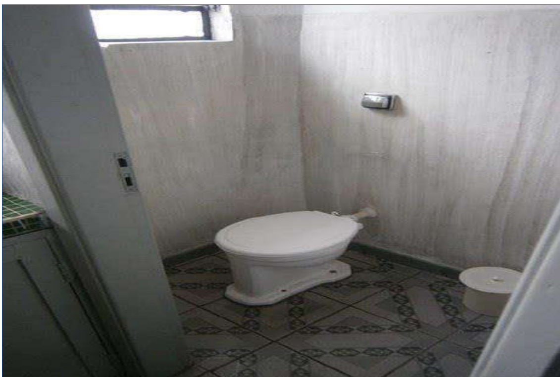
FOTO nº 13 Vista do banheiro masculino no pavimento superior.
