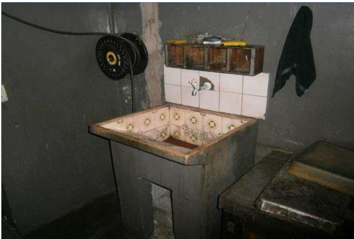
FOTO nº 23 Vista do tanque no pavimento inferior.
