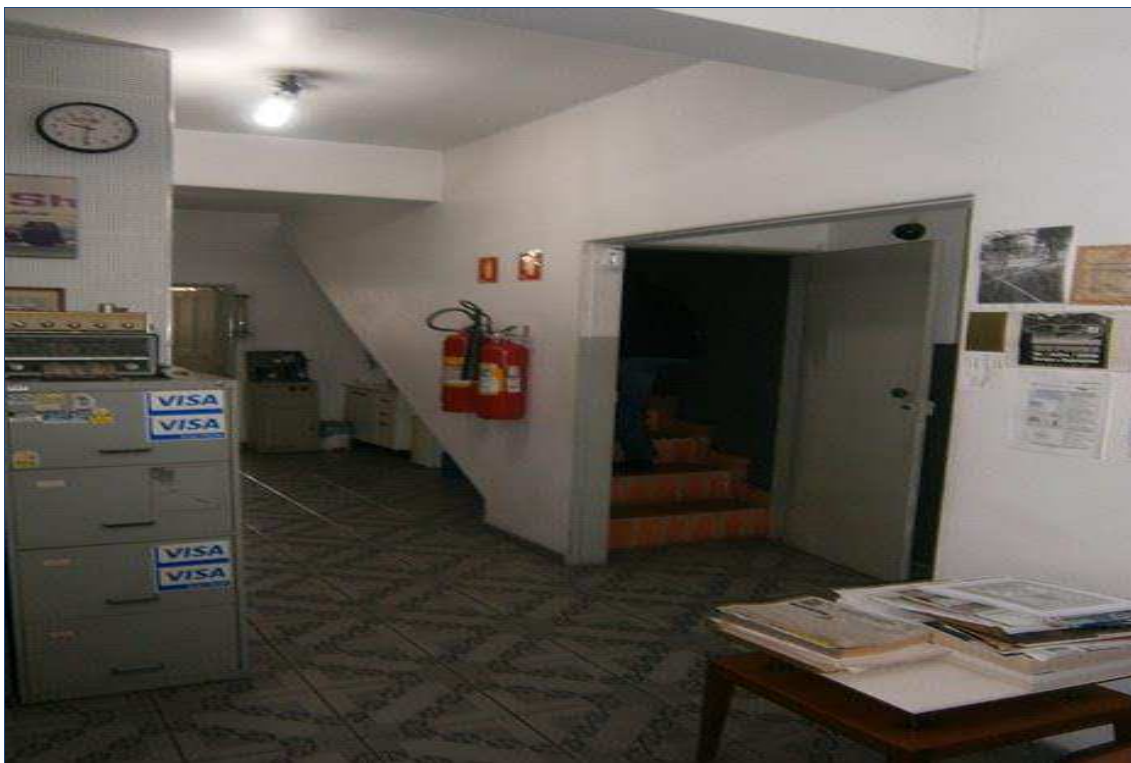
FOTO nº 15 Vista da escadaria entre os pavimentos superior e cobertura.
