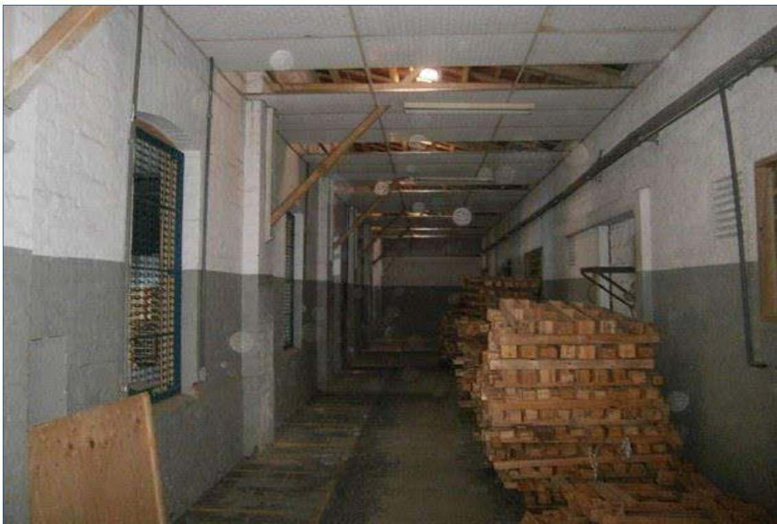
FOTO nº 17 Vista da área periférica do Galpão.
