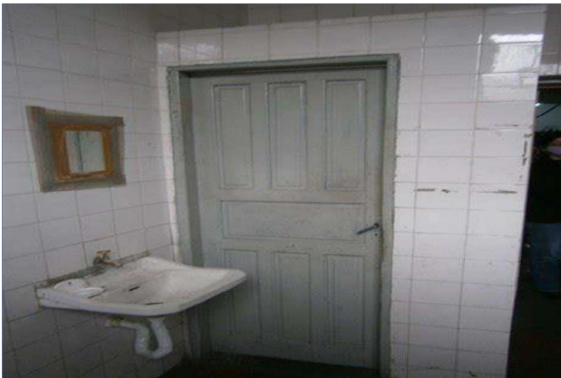
FOTO nº 25 Vista do lavatório e banheiro no pavimento inferior.
