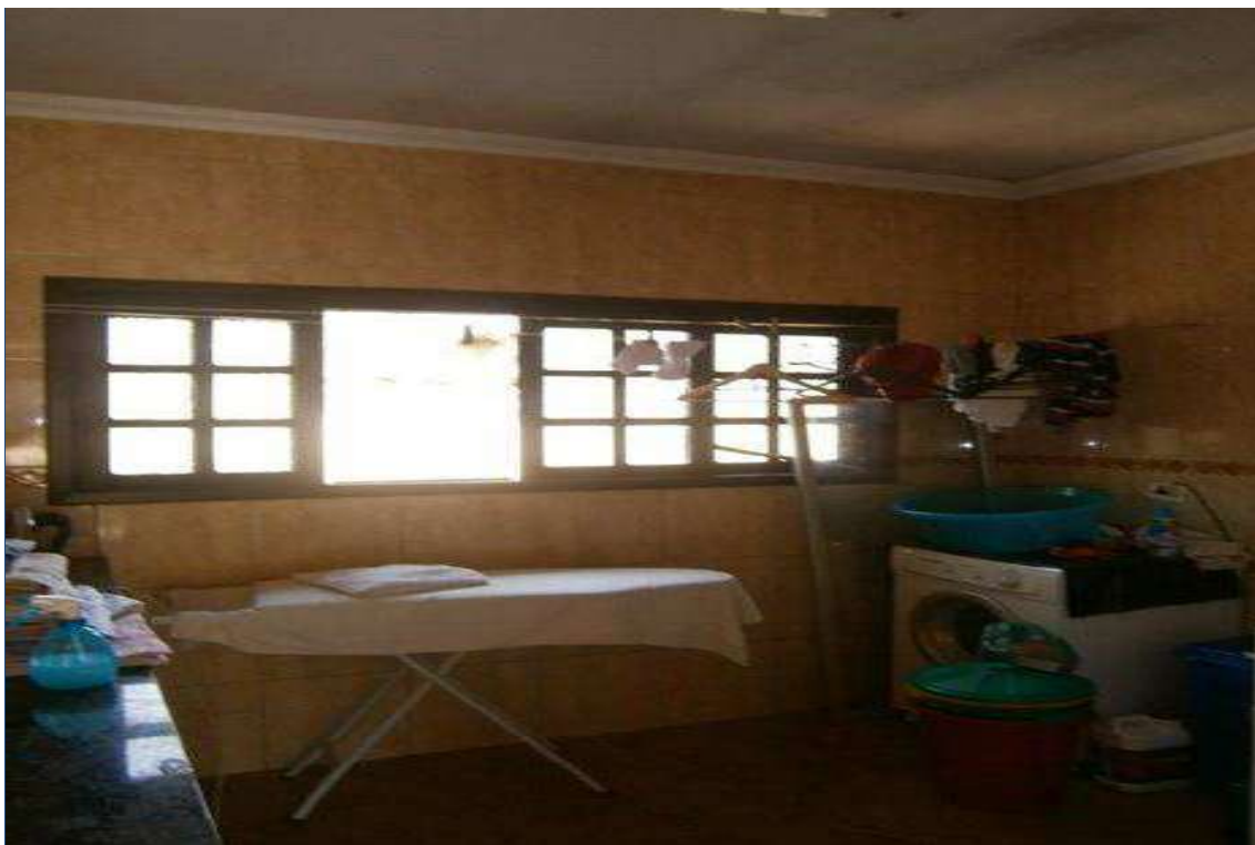
FOTO nº 20 Vista da lavanderia na Casa Térrea Principal.
