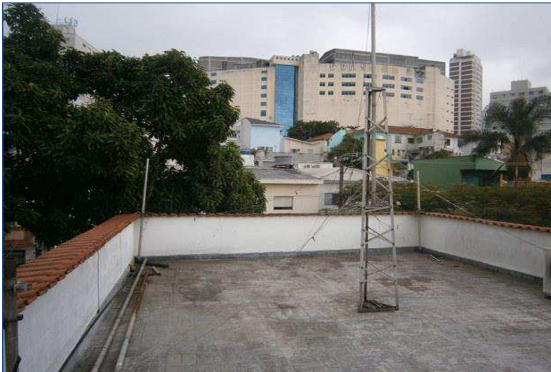
FOTO nº 18 Vista do terraço na cobertura.
