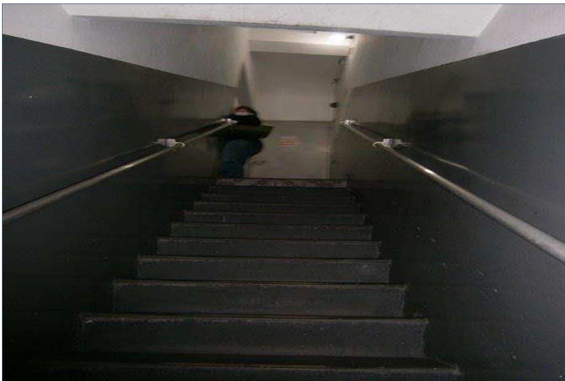
FOTO nº 05 Vista da escadaria entre os pavimentos térreo e superior.
