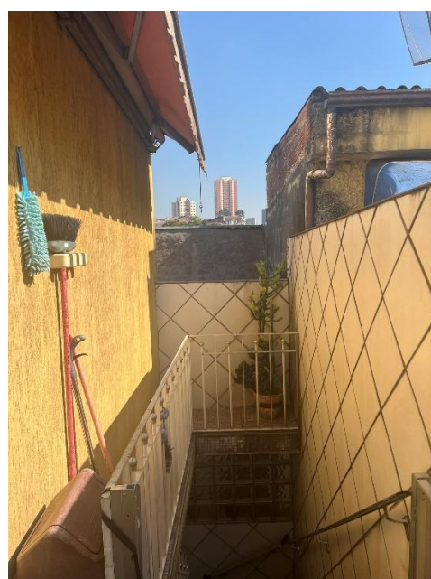
Escada de acesso ao 1º Pavimento
