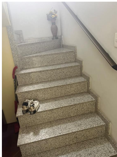
Escada para o 3º Pavimento
