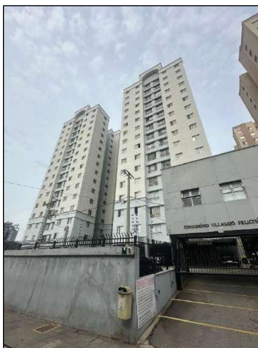
Vista panorâmica dos edifícios
